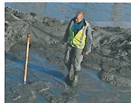
Het versterkt sediment is binnen vier uur begaanbaar.
