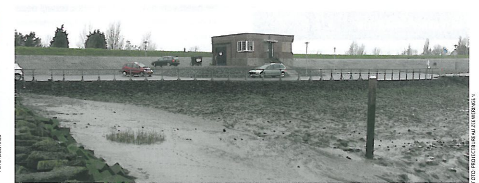
Eindsituatie met het aangebrachte talud.
