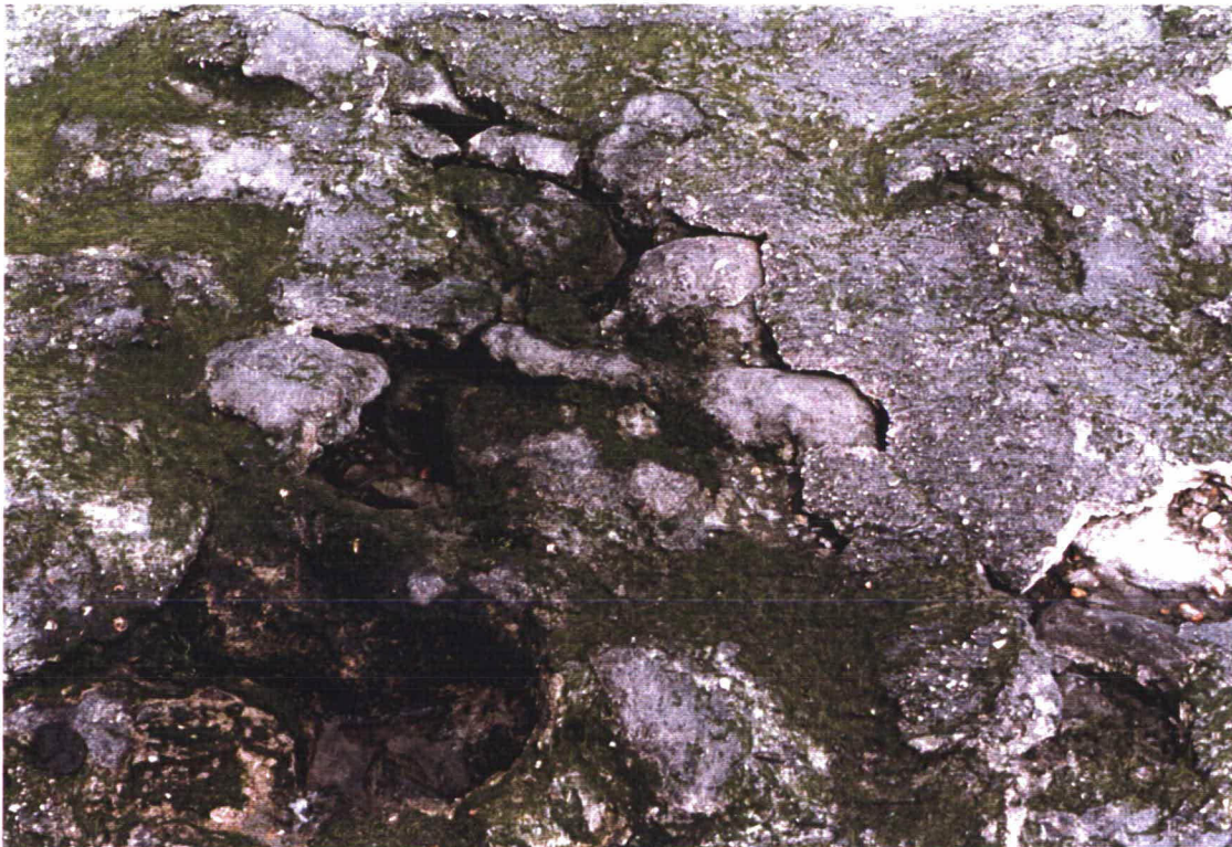
Foto 5: Overzicht van de locatie met beton geopenetreerde Vilvoordse steen. Genomen bij km 15,8 in oostelijke richting.
