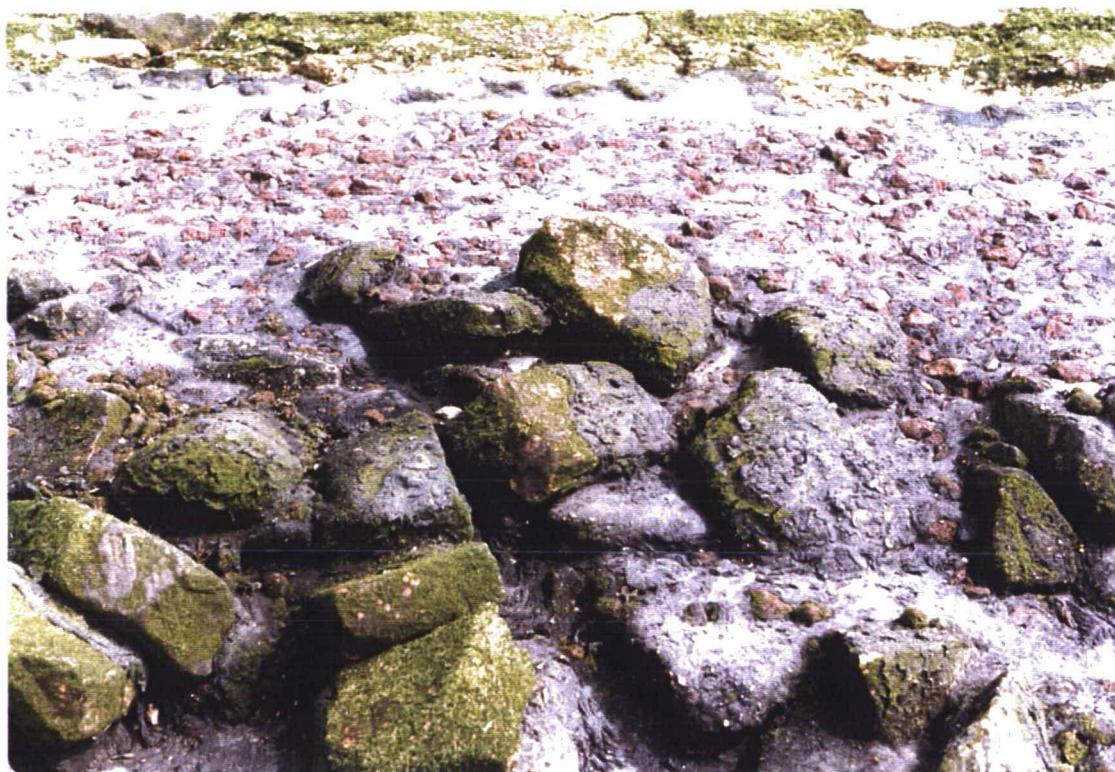
Foto 4: De overgangsberm aan de bovenzijde van de bekleding (km 15).
