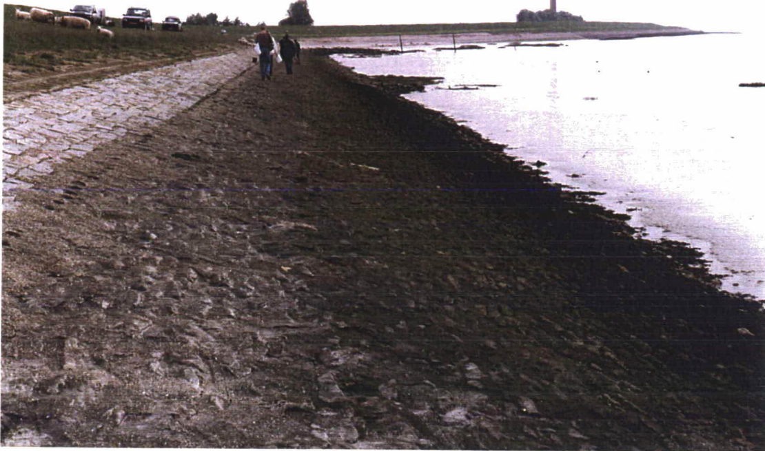
Foto 5: Overzicht van de locatie met beton geopenetreerde Vilvoordse steen. Genomen bij km 15,8 in oostelijke richting.
