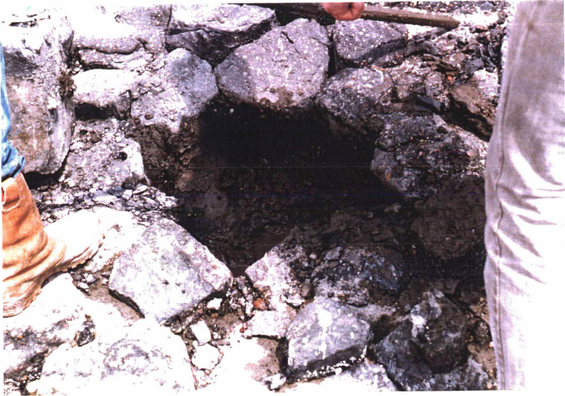
Foto 15 Gat in de bekleding bij km. 16,6. Er blijkt nog water onder de bekleding aanwezig te zijn.
