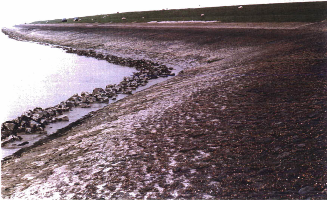
Foto 13 Overzicht van het rechte stuk van de met asfalt gepenetreerde basalt (km 16,4, genomen in westelijke richting)..
