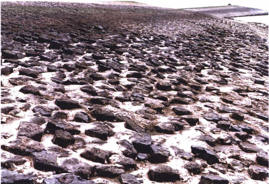
Foto 15 Gat in de bekleding bij km. 16,6. Er blijkt nog water onder de bekleding aanwezig te zijn.
