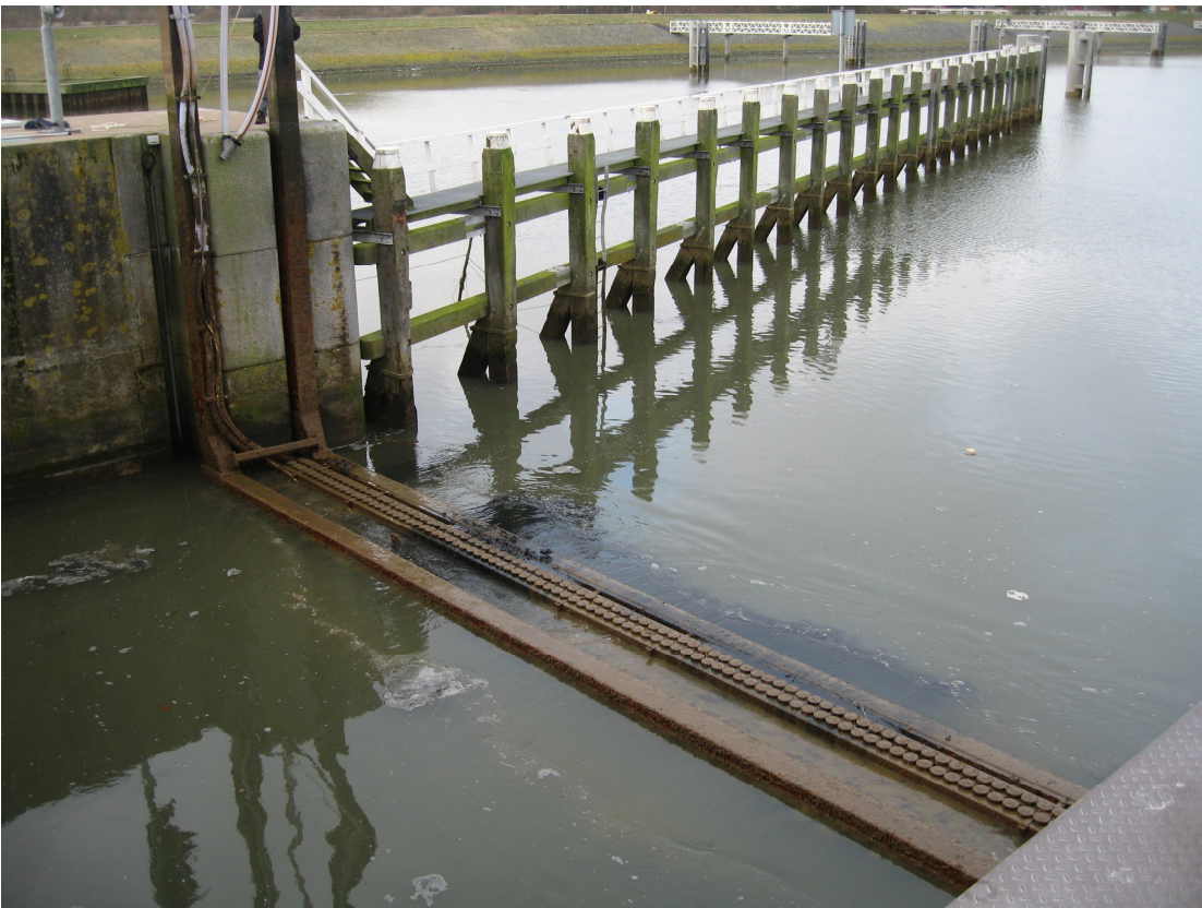
Figuur 5.2 \Delta -luchtbellenscherm in de Stevinsluis (Waddenzeezijde) tijdens uitnemen op 13 december 2010
