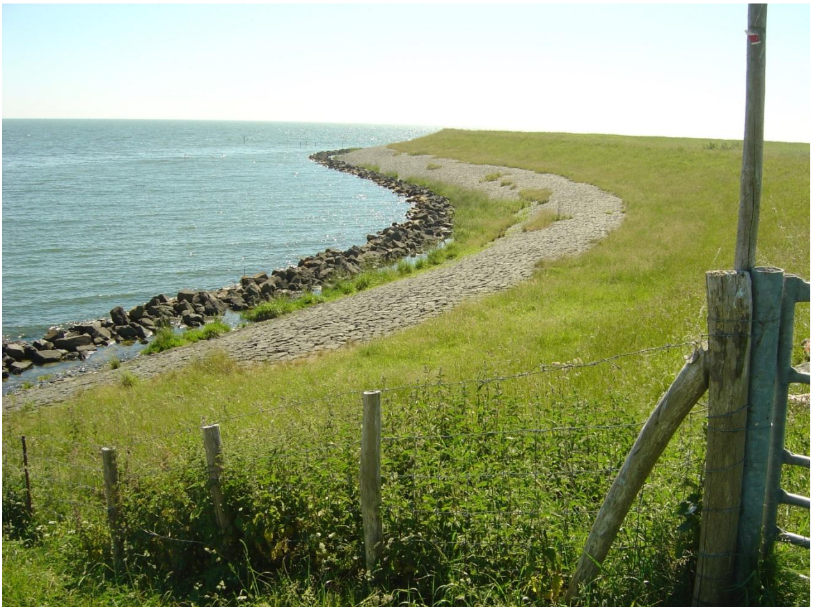
Figuur 1.1 Breuksteen op de waterlijn en op 1:3 talud daaronder (Wieringermeerdijk langs het IJsselmeer)
