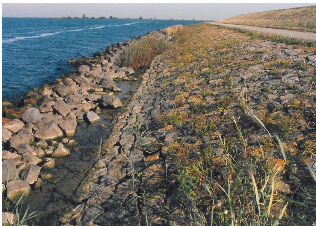
Figuur 5.1 Dijk bij Pampushaven langs Markermeer
