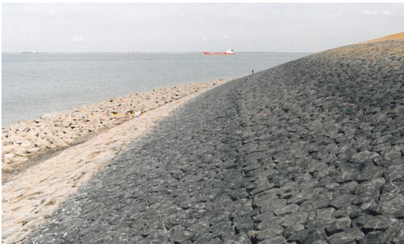
Figuur 2.4 Dijk aan de westzijde van Terneuzen met breuksteen aan de teen
