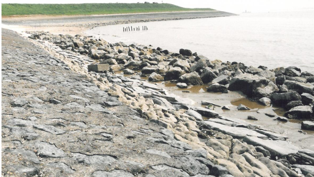
Figuur 2.3 Teenbestorting van dijk bij Waarde (Westerschelde)
