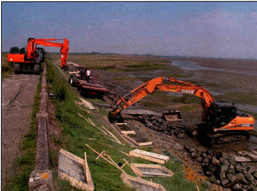
Foto 4 Viane: Rooien (voorgond) en vervoer (achter) van zeegrasplaggen
