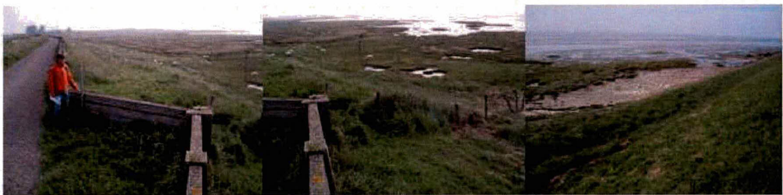
3 foto's op hetzelfde punt genomen, rechts zie je de doorgang naar het slik
