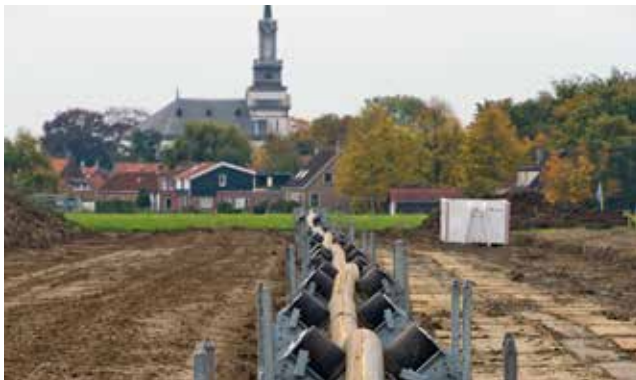
Foto 4.4 Aanleg nieuwe kruising Veerse Meer
