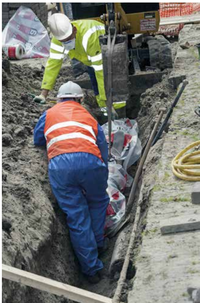
Foto 5.1 Het vervangen van asbestcement leidingen in Middelburg
