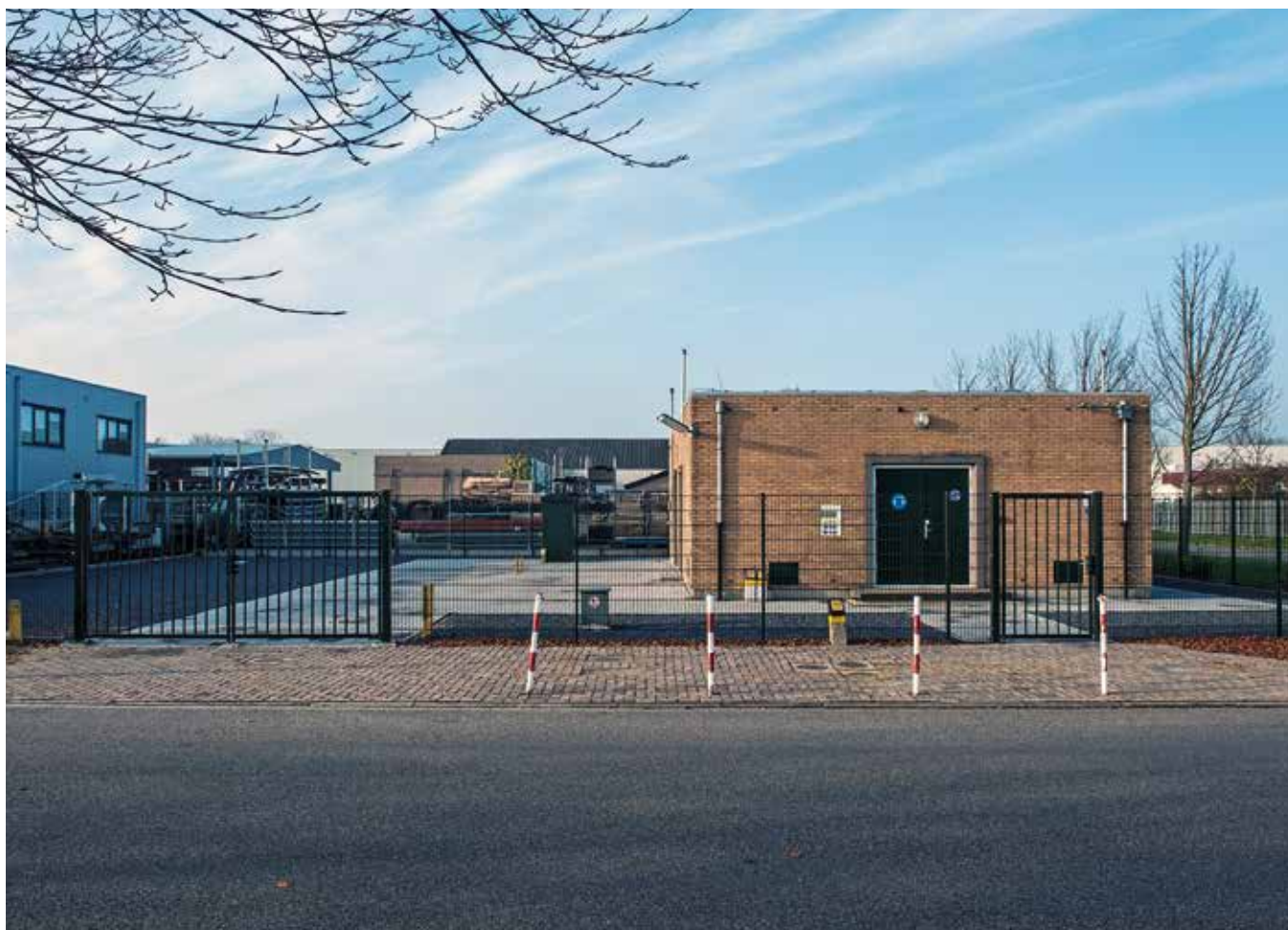
Foto 4.7 Groot onderhoud van GOS-terrein Middelburg
