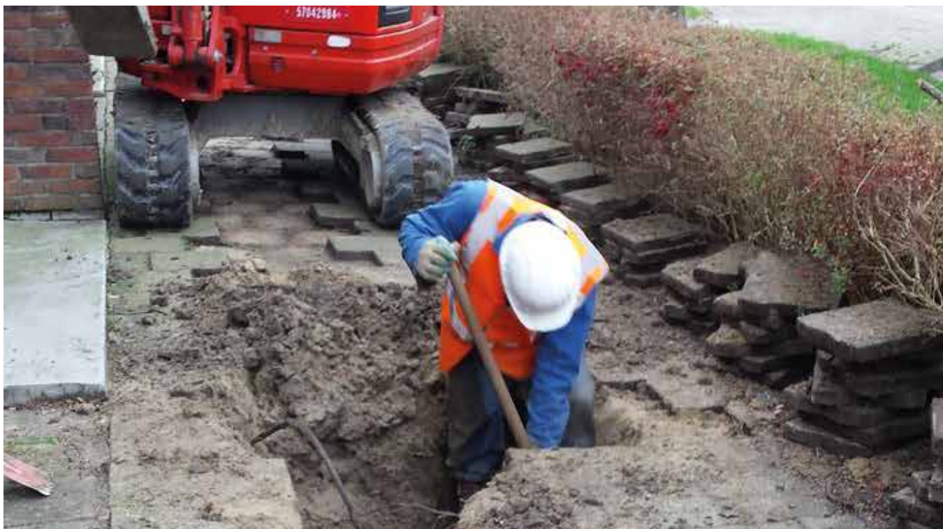
Foto 4.3 Graafwerkzaamheden zijn een belangrijk risico voor Enduris
