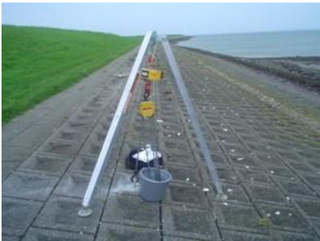
Figuur 4.5 Voorbeeld van de trekproef met driepoot. De driepoot is correct geplaatst: geen enkele poot staat op een blok wat direct grenst aan het blok waaraan wordt getrokken. Maar de overmaat aan ketting van het hijsblok vormt extra excentrisch gewicht op de steen waar aan wordt getrokken: zo moet het niet
