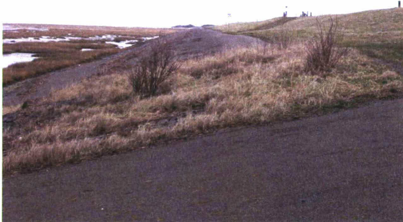
Figuur 2.2 Ter hoogte van de voormalige uitwateringssluis (dp309) zijn basaltzuilen in de boventafel aanwezig, in plaats van het asfaltbeton of grindasfaltbeton in rest van de boventafel. Tussen de basaltzuilen is duidelijk meer begroeiing aanwezig.
