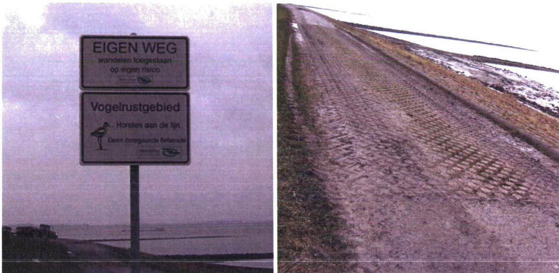
Figuur 1.3 Het buitendijks onderhoudspad is ter hoogte van dp298 afgesloten voor fietsers. De rechterfoto laat de 'barrière' zien waarmee het onderhoudspad in de huidige situatie onaantrekkelijk gemaakt is voor fietsers (geribbelde stenen over een korte lengte).
