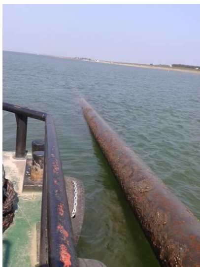
Figuur 56 – Zinker leiding start luchtpomp
