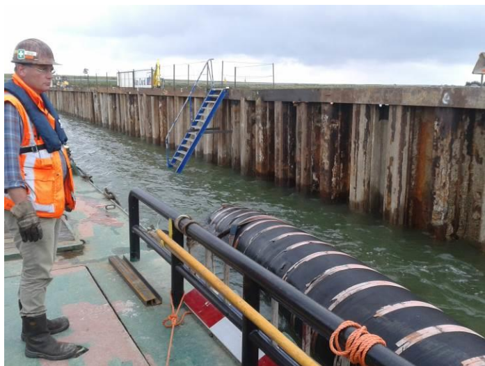
Figuur 60 – Aanleg afmeerdrijver
