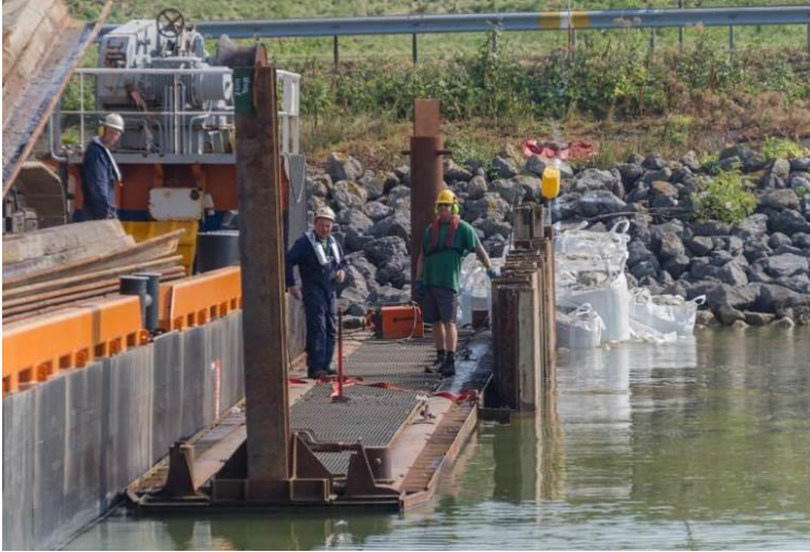
Figuur 8 – Aanbrengen damwand
