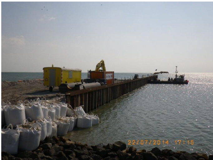
Figuur 46 - Geocontainers
