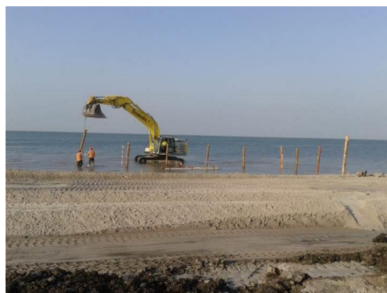
Figuur 17 – Palen inbrengen
