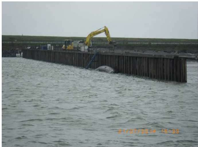
Figuur 39 – Damwand gereed
