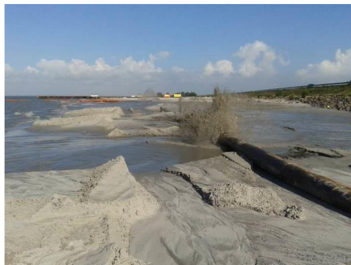
Figuur 44 – Landleidingen in werking
