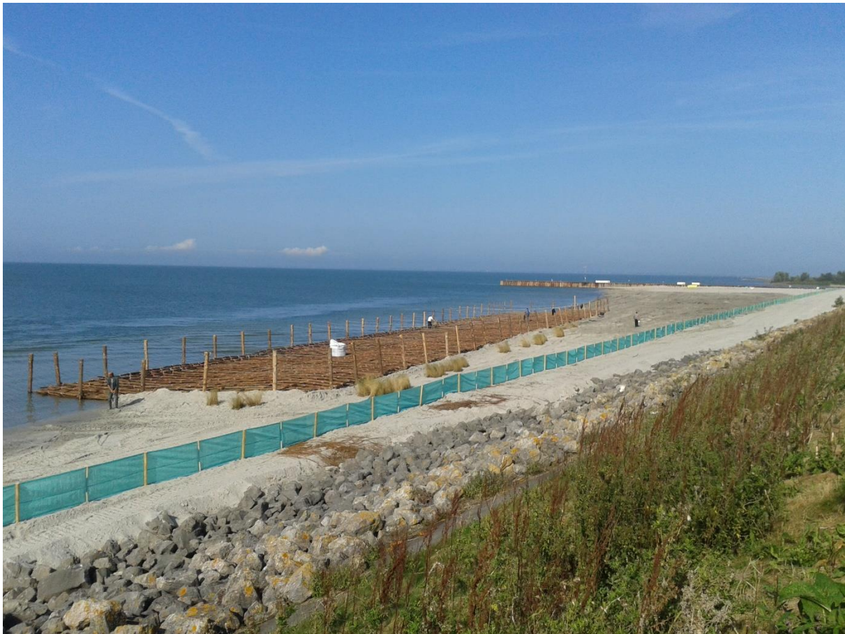
Figuur 21 – Overzicht zinkstuk en stuifscherm
