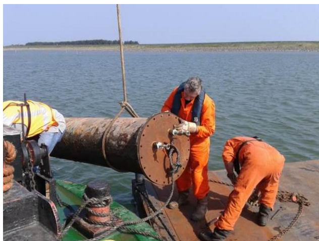
Figuur 54 – Installeren luchtpomp
