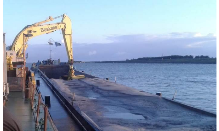
Figuur 31 – Hydraulische graafmachine, loskraan
