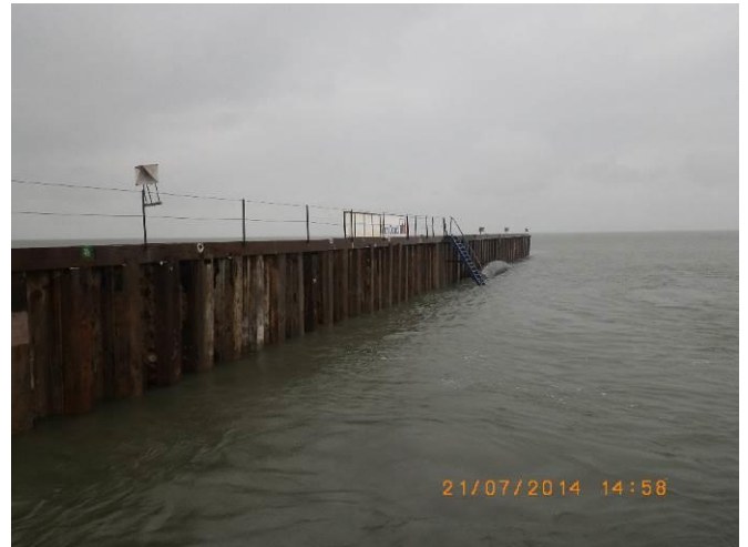
Figuur 40 – Damwand gereed
