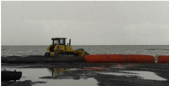
Figuur 26 – Bulldozer, stort
