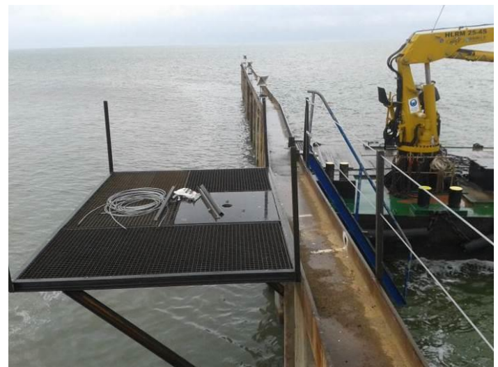
Figuur 11 – Damwand afmaken en voorzieningen meetpaal
