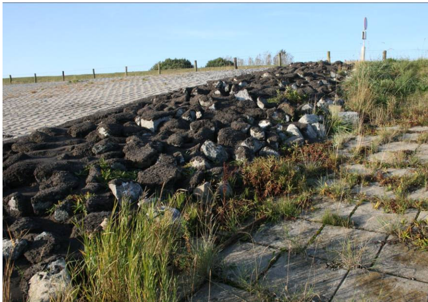
Figuur 2.3 Overgang reeds voltooide dijktraject Westelijke Sloehavendam (links) naar het te realiseren Schorerpolderdijk traject (rechts).
