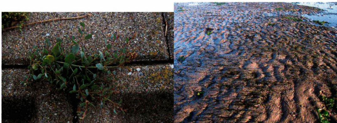
Foto 4.1: Planten (gewone zoutmelde en klein zeegras) op resp. de steenbekleding en het voorland van het dijktraject St. Pieterspolder, Nieuw Olzendepolder.
