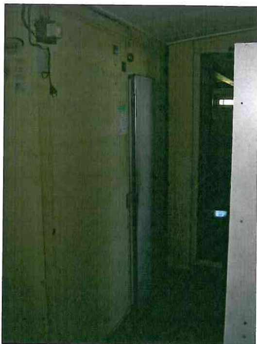
Foto 2151: aanzicht koelcel met toegangsdeur, paviljoen
