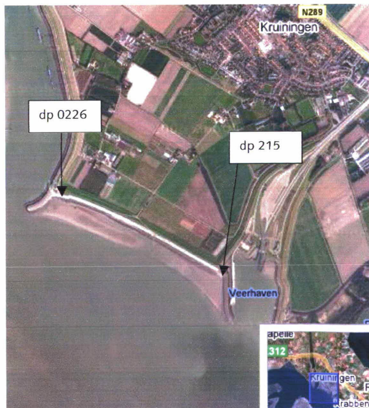
Figuur 1: Luchtfoto Kruiningenpolder dp 0215 – dp 0226 (bron: www.maps.google.nl )
