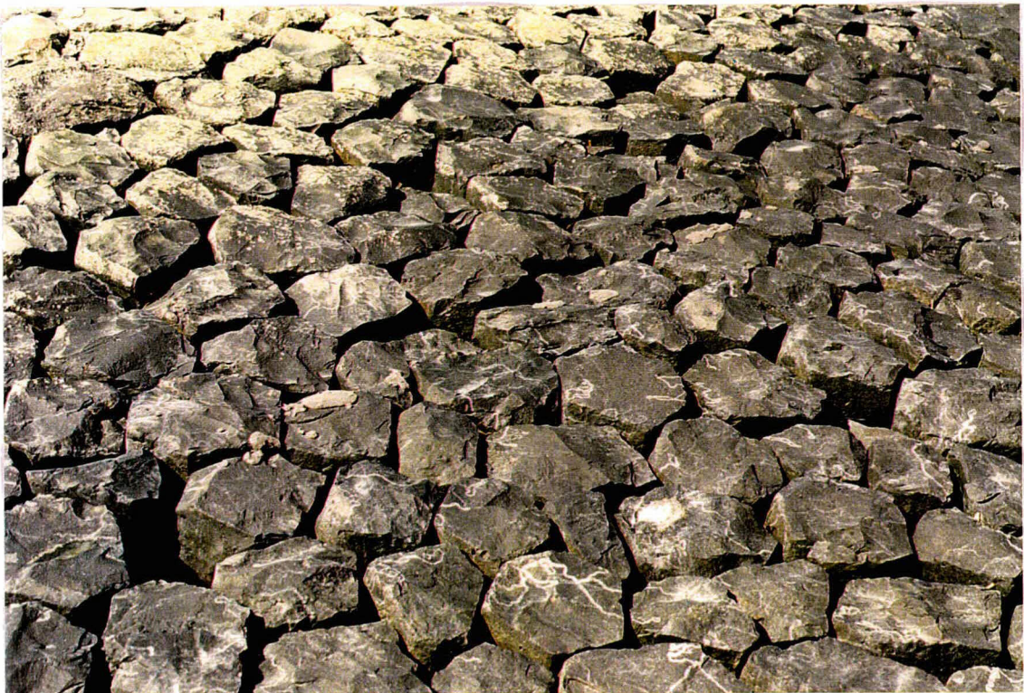
Foto 6 Voorbeeld van een lokatie waar de stenen wat verzakt lijken. Enkele zuilen zijn een flink stuk het talud ingezakt.
