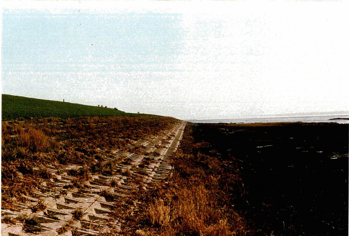
Foto 1 Overzicht van de lokatie, met onderin de basalt en hierboven de overgoten basalt
