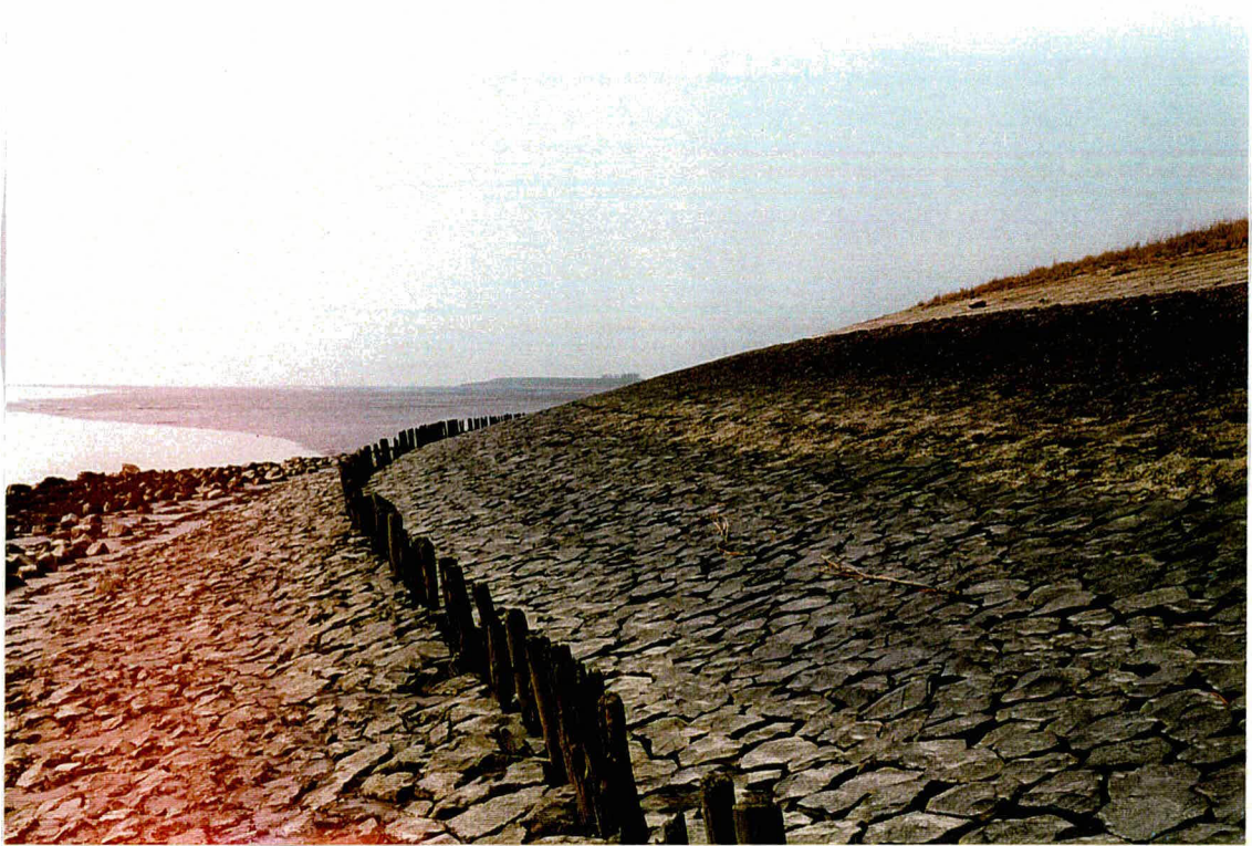
Foto 1 Overzicht van de lokatie, met onderin de basalt en hierboven de overgoten basalt
