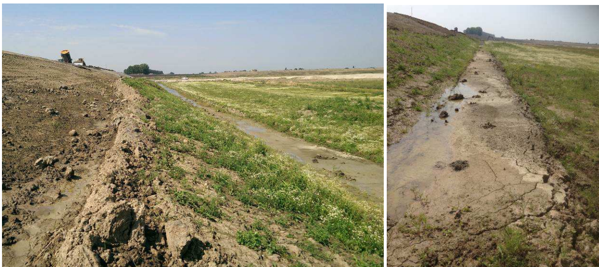
Figuur A.2 en A.3: Zicht in westelijke richting van de gevulde sleuf bij de buitenteen
