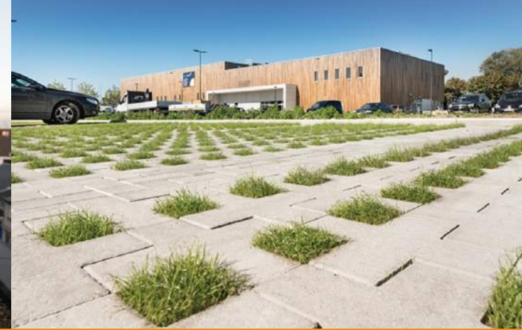
Afbeelding: Grasbetontegels op een parkeerplaats in Schiervelde in België (bron: https://www.struykverwoinfra.nl/N-299/square-cross-zorgt-voor-groene-parkeerplaats ).
