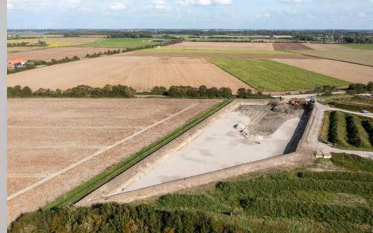
Afbeelding: De zuiveringsinstallatie bij Camping Olmenveld (foto verkregen via J. Olmenveld, Camping Olmenveld)
