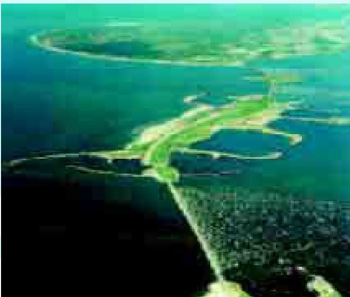
Stormvloedkering vanuit de lucht.
