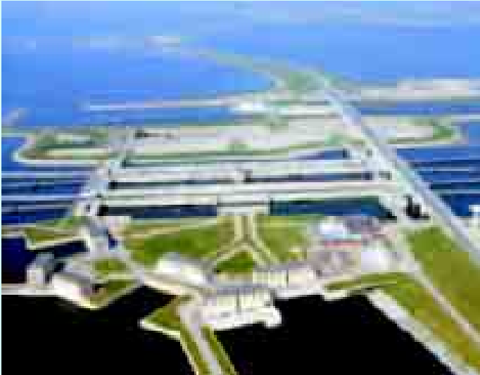
De Krammersluizen in de Philipsdam.
