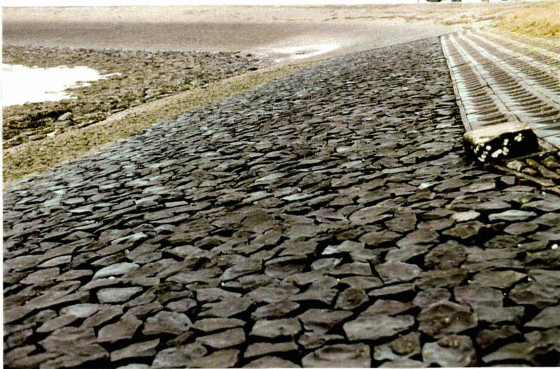
Foto 3 Overzicht van vak 22503 in westelijke richting. Voorbij de bocht loopt de strekdam van het Kanaal door Zuid-Beveland
