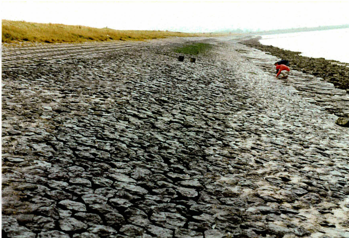
Foto 5 Vak 22302 (niet gepenetreerde basalt) ligt midden in een vak gepenetreerde basalt. Aan de bovenzijde en aan de onderzijde van het vak is de basalt gepenetreerd.
