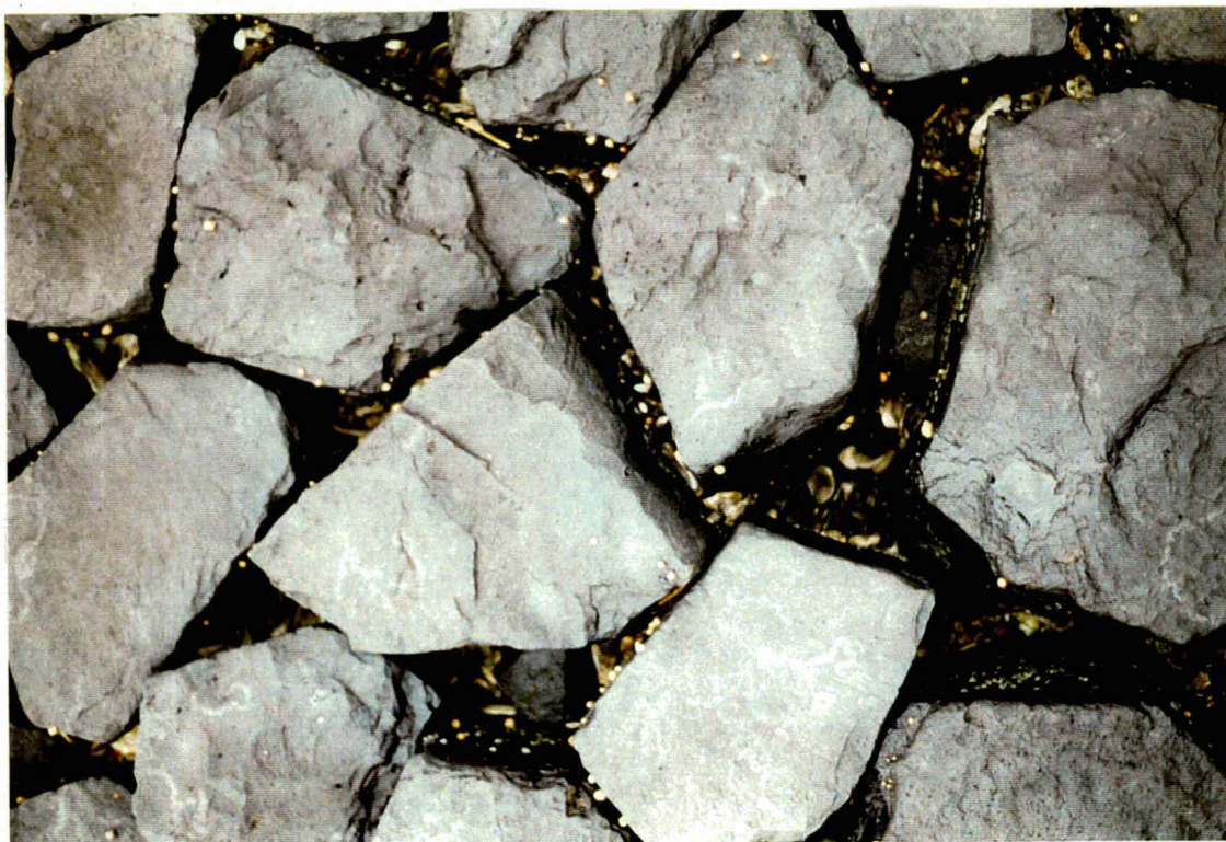
Foto 4 Basalt (vak 22503): de zuilen zijn hier en daar los gezet. De spleten zijn wel goed gevuld met steentjes, slib en schelpen.
