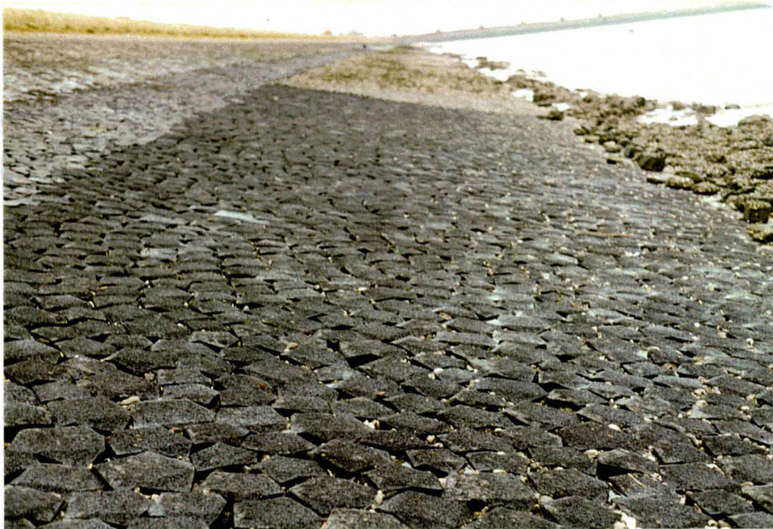
Foto 7 Vak 22001: basalten laag op het talud.
