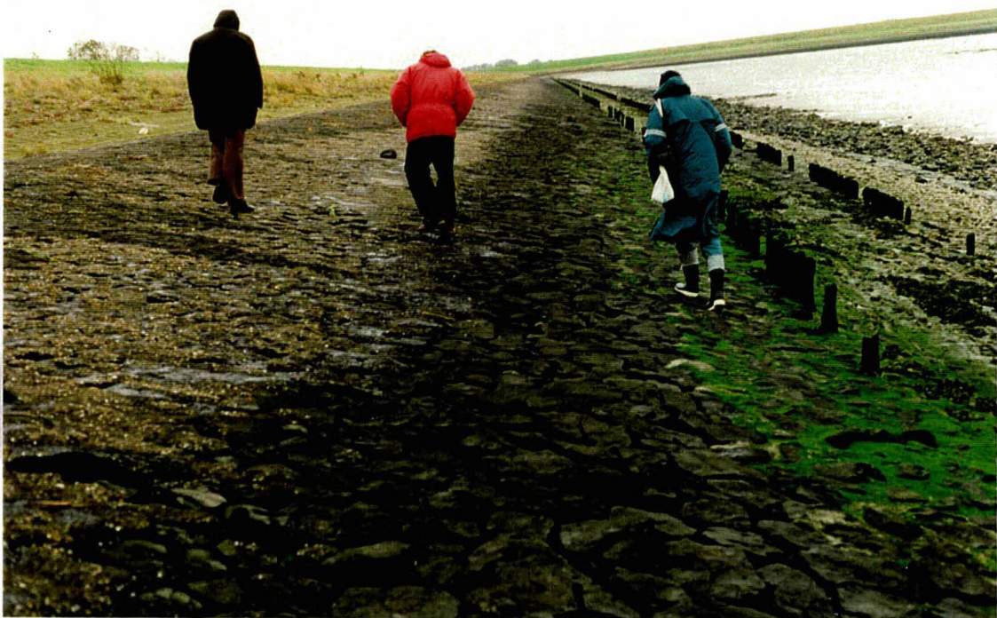
Foto 26 Overzicht bekledingen 18901 (strook met beton geopenetreerde basalt boven de palenrij) en 18604 (met asfalt geopenetreerde basalt aan de bovenzijde)
