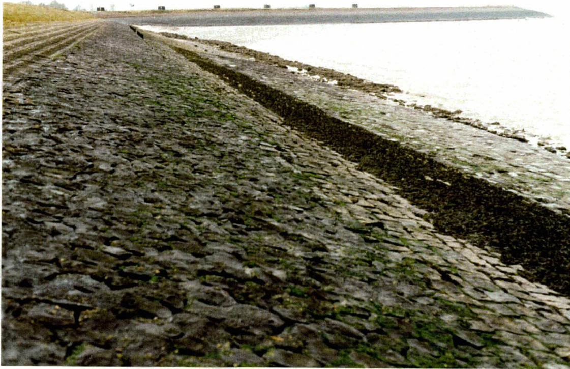
Foto 11 Overzicht van vak 21512 bij km 21,8 in oostwaartse richting. Aan de onderzijde van dit vak zit petit graniet ingegoten met beton. Op de achtergrond ligt de strekdam van de veerhaven.
