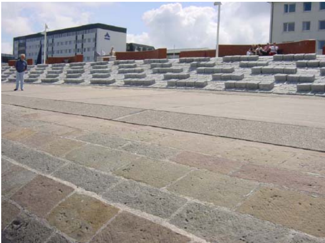
Figuur 5.2: Ribbels als ruwheidelementen op taludbekleding Norderney (Noord Duitsland)
