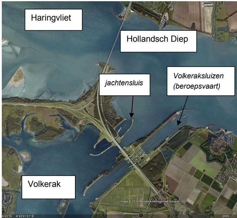
Figuur 1.1 De Volkeraksluizen vormen de verbinding tussen het Volkerak en het Hollandsch Diep. De scheepvaartsluizen bestaan uit 3 beroepsvaartsluizen en 1 jachtensluis. Tussen beide sluisencomplexen bevindt zich een spuisluis (Bron: Google Earth)
