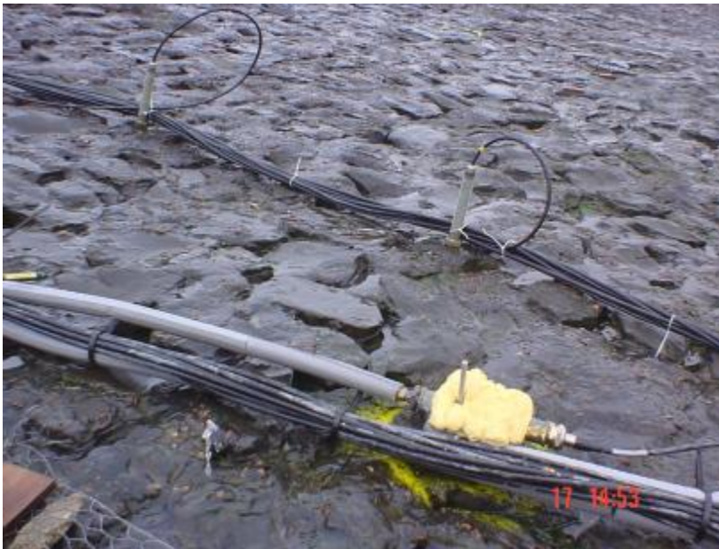
Figuur 3.4 Detail meetraai, op de voorgrond is een opnemer voor het meten van de verplaatsing van de toplaag, op de achtergrond twee opnemers voor het meten van de waterdruk in de granulaire laag.
