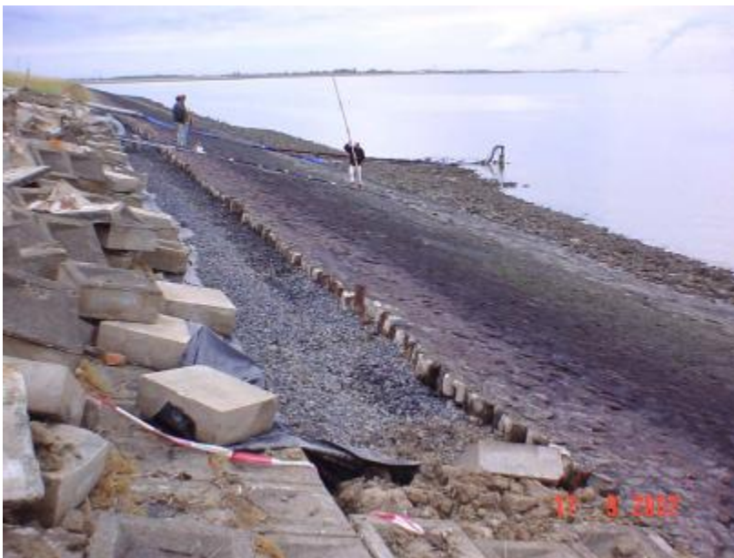
Figuur 6.3 Meetlocatie Willem-Anna polder, de infiltratiesloot staat droog, op de achtergrond is de pomp nog net zichtbaar
