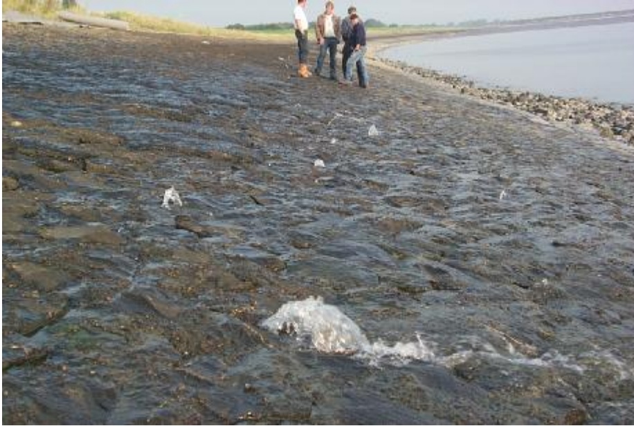
Figuur 4.8 Uittredend water door de toplaag
