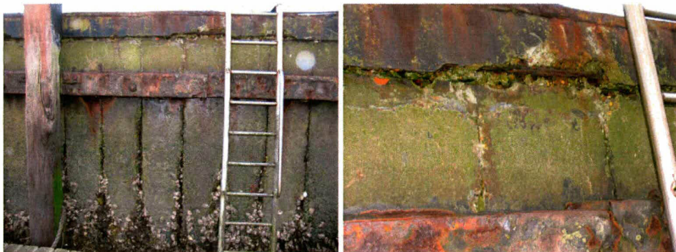
Figuur 2.4 Bestaande betonnen damwandconstructie
