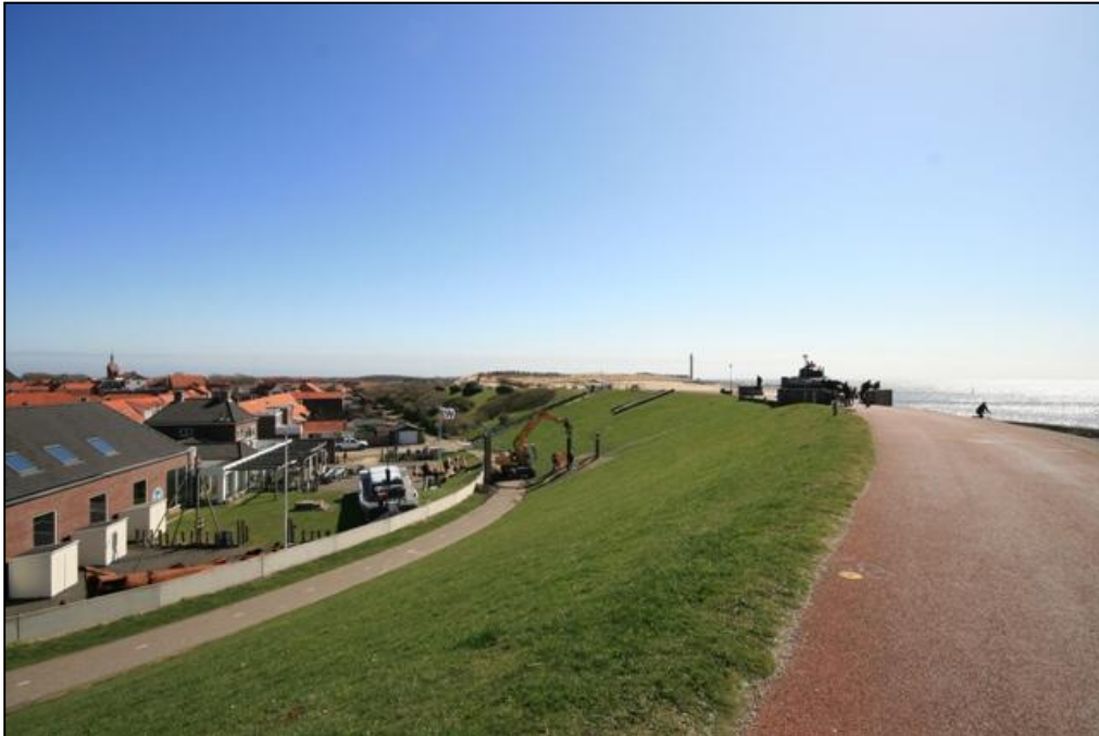
Figuur 9.1. Werkgebied A ter hoogte van dijkpaal 210.
