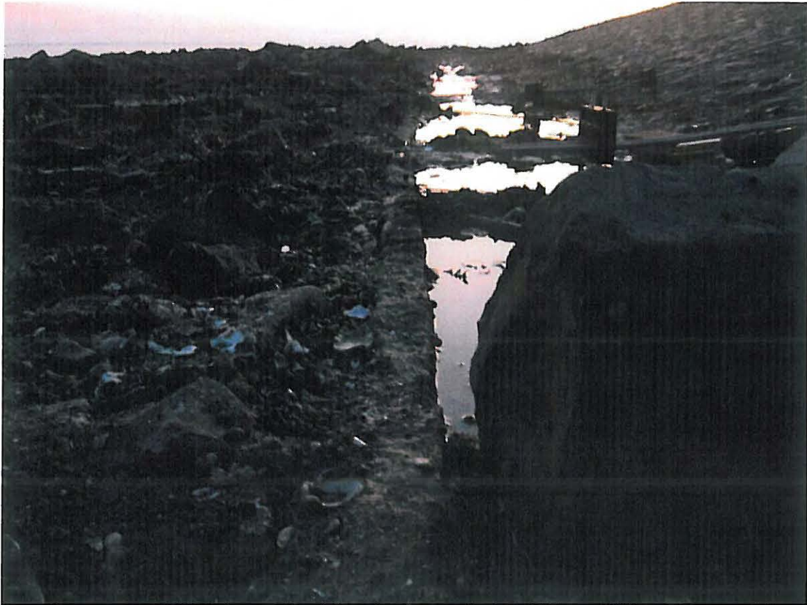
Foto 9: Vervorming van de teenconstructie onder belasting
