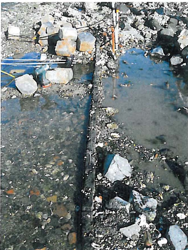
Foto 8: Vervorming teenconstructie onder belasting
