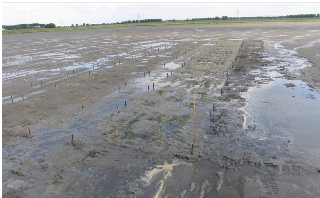
Foto 5: De mitigatielocatie na beëindiging van de werkzaamheden en afvlakken, 9 juni 2011
