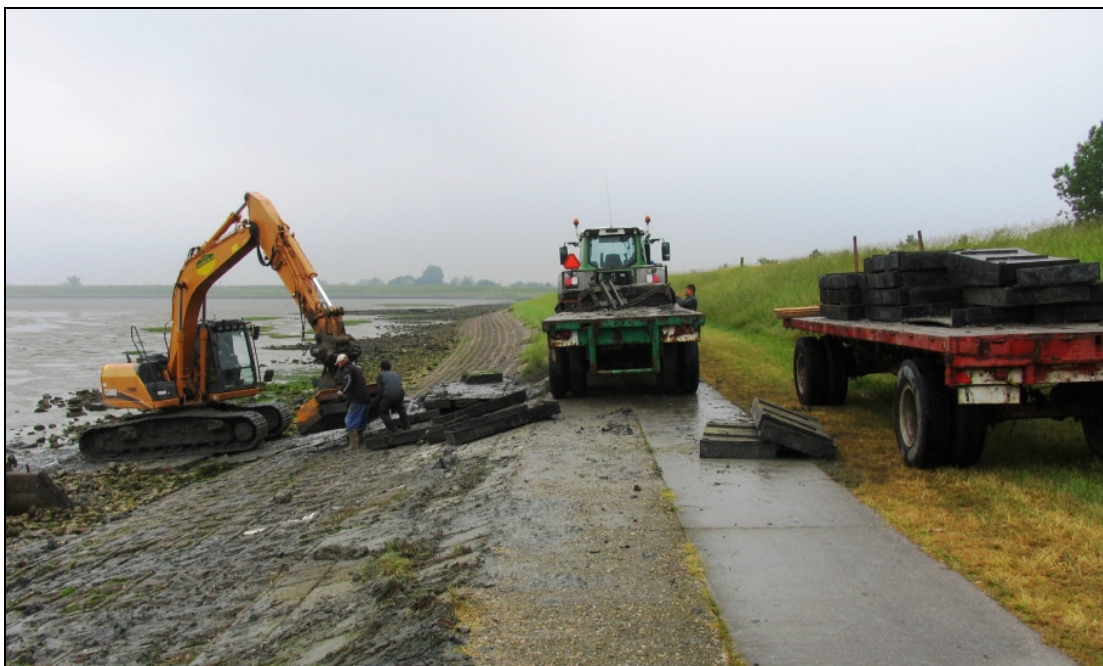
Foto 1: Werkzaamheden op donorlocatie Goesse Sas, 6 juni 2011
