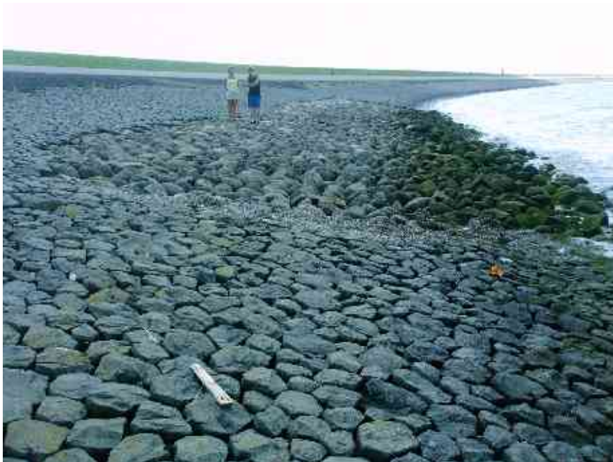
Foto 3.5 Benedentalud: basalt en Noorse steen
