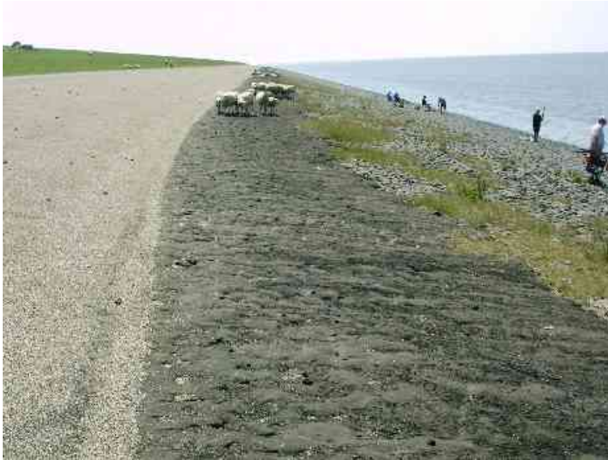
Foto 3.4 Boventalud (gras), berm (asfalt) en benedentalud (eerst gepenetreerde basalt en daarna basalt).
