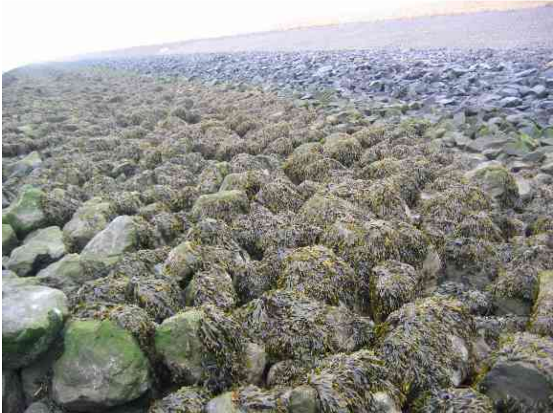
Foto 2.8. Doornikse kalksteen (300-1000 kg) gestort in de berm en op de dijkvoet (Westerschelde, nabij Borssele). Gebruik van uniforme steensortering met losse storting levert zeer variabele holtes op. Hoogteligging bepaald sterk de soortensamenstelling die wordt aangetroffen.
