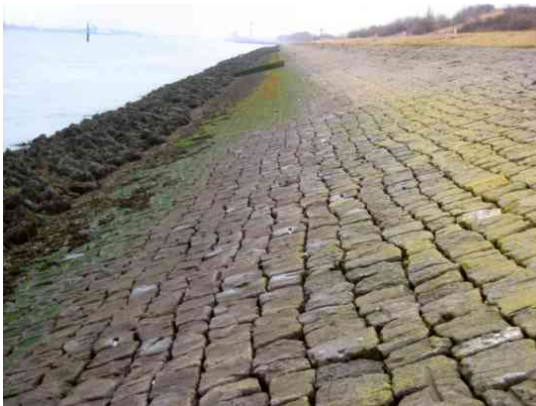
Foto 2.10. Substraat type beïnvloedt de hoogte waarop soorten op een dijktalud kunnen voorkomen. Zie de verspringing in de groen bruin algen zone halverwege de foto, Nieuwe Waterweg, tegenover Stena Line, Hoek van Holland.
