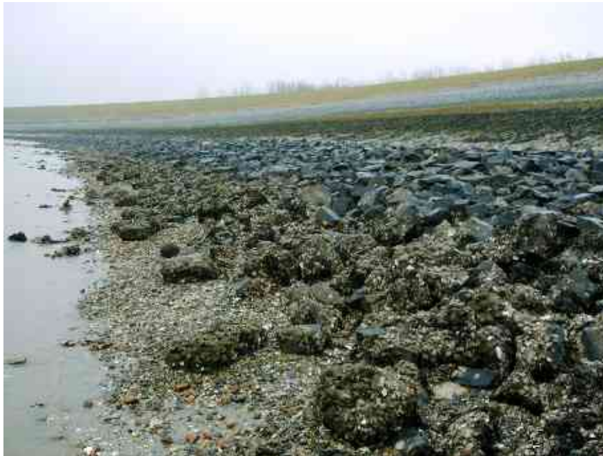
Foto 3.6 Een kreukelberm als teenconstructie
