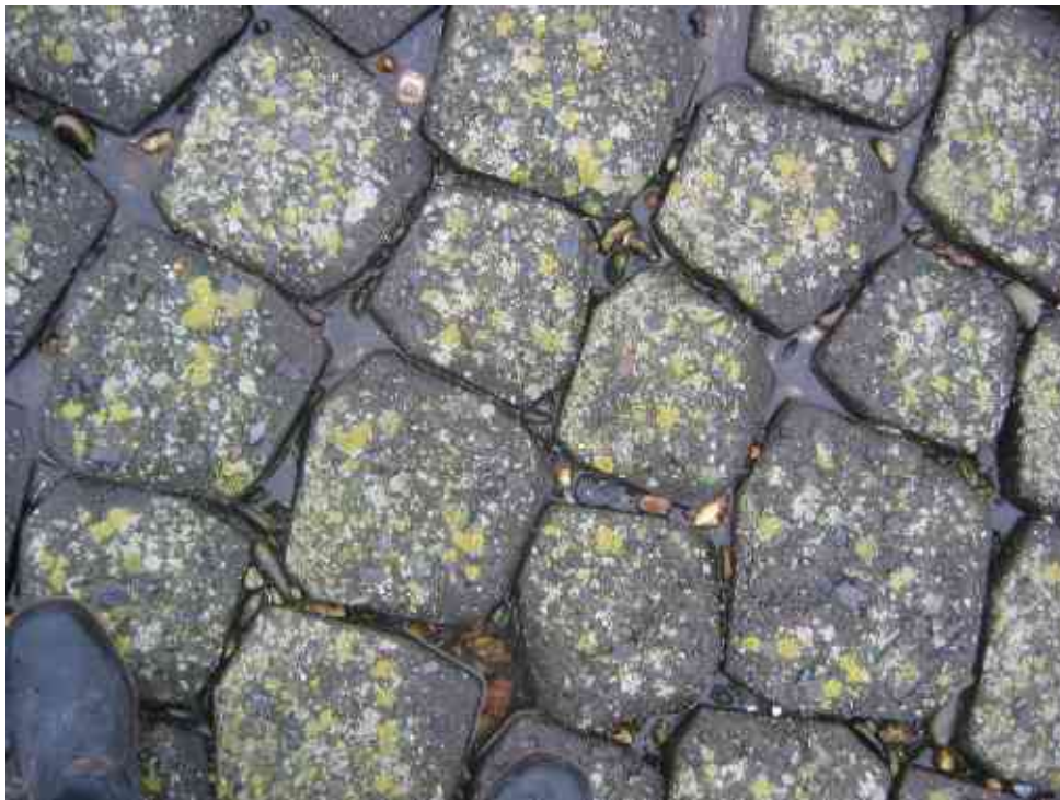
Foto 2.6. Basalton substraat (20x20cm blokken) met daartussen spleten op centimeter schaal. De spleten werden weer opgevuld met losse steenslag om de Basalton te fixeren. Kleine poeltjes worden gevuld door golfploep. Locatie: hoog in het intergetijdegebied, met aangroei van korstmossen (gele kolonies).
