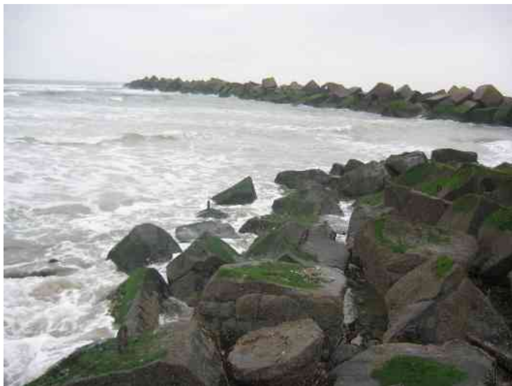
Foto 2.1. Geëxponeerd hard substraat (breuksteen - onderste deel foto) nabij Blokkendam (bovenste deel foto) op de Maasvlakte. Op iets luwe locaties treffen we al groenwieren ( Enteromorpha sp.) aan. Substraat is Doornikse kalksteen van 1-3 ton.
