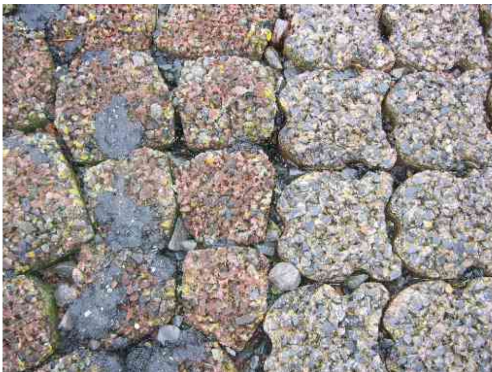
Foto 2.7. Twee typen blokken met eco-toplaag zoals gebruikt langs de Westerschelde. De blokken zijn ontworpen, door gebruik van een extra open laag van kleine stortsteen, om aangroei met wieren te versterken. De roodgekleurde blokken (links) maken gebruik van lavasteen als toplaag. De Hydroblocks (rechts) hebben een toplaag van open colloïdaal
