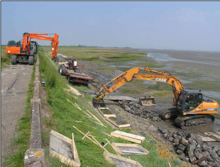
Figuur 4 Twee kranen in gebruik bij rooien van plaggen op donorlocatie
