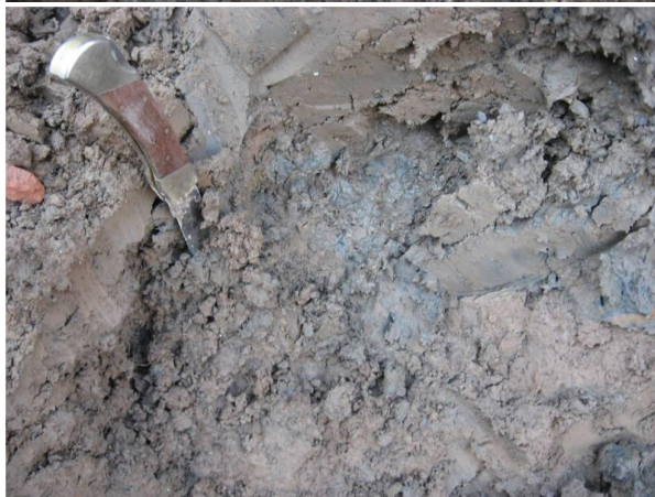
Figuur 4.2 Overzicht, boven, van een verzakking van een dijktalud enige weken na aanleg. Het talud bestaat uit kleigrond die bijna niet is verdicht. Op sommige locaties is de met een bulldozer verdichte slag aangebrachte grond 0.9 m dik, op andere locaties is de slagdikte meestal meer dan 0.5 m. De foto links foto geeft een overzicht van losgepakte kleikruimels en kluiten in de kleilaag. (verdichtingsgegevens bekend bij Deltares: J.E.J. Blinde, J. Dekker, G.A.M. Kruse, M.J.M. Wijnberg)
