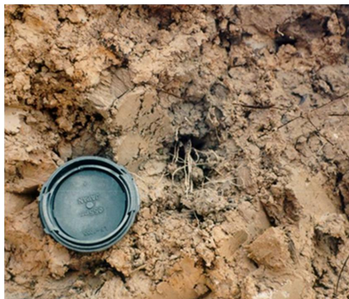
Figuur 4.3 Een grote open ruimte in een kleipakket zoals die aanwezig is in het onderste deel van een aangebrachte 0,4 m dikke slag die verdicht is. Een gestoken monster van deze grond bleek met holle ruimte een Proctordichtheid van 103 % te hebben op basis van een volledige Proctorproef op de ter plaatse bemonsterde grond (verdichtingsgegevens bekend bij Deltares: J. Dekker, G.A.M. Kruse)
