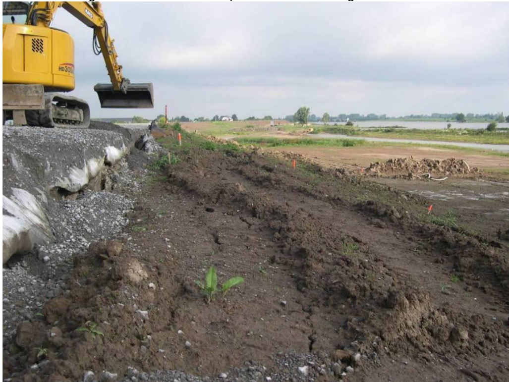
Figuur 4.2 Overzicht, boven, van een verzakking van een dijktalud enige weken na aanleg. Het talud bestaat uit kleigrond die bijna niet is verdicht. Op sommige locaties is de met een bulldozer verdichte slag aangebrachte grond 0.9 m dik, op andere locaties is de slagdikte meestal meer dan 0.5 m. De foto links foto geeft een overzicht van losgepakte kleikruimels en kluiten in de kleilaag. (verdichtingsgegevens bekend bij Deltares: J.E.J. Blinde, J. Dekker, G.A.M. Kruse, M.J.M. Wijnberg)
