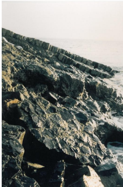
Figuur 3.4 Schade aan een havenhoofd na een zware storm. Slechts de sterk door bodemvorming beïnvloede kleigrond in de aangevallen zone is verdwenen en de compacte klei, bijna zonder bodemstructuur is bijna niet aangetast
