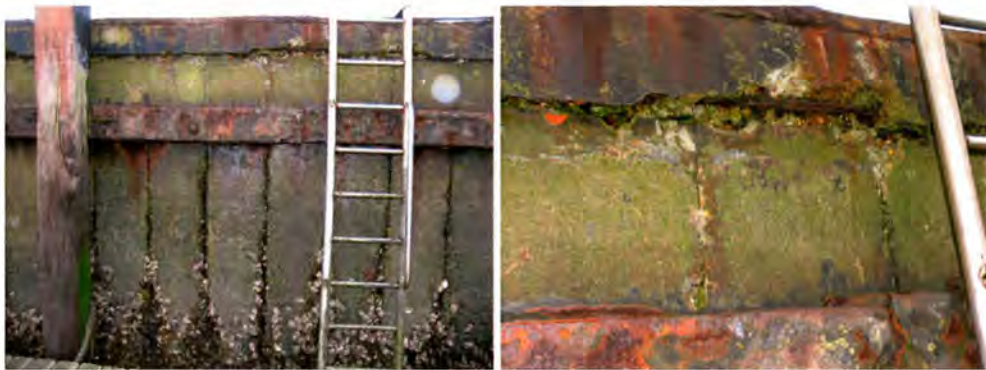
Figuur 2.4 Bestaande betonnen damwandconstructie
