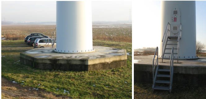
Figuur 21 Windmolenfunderingen Windmolenpark Halsteren met windmolenschacht.
