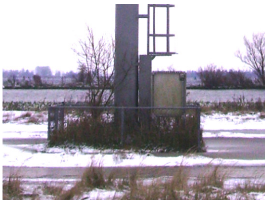
Figuur 24 Schakelkast lichtopstanden Krammerse Slikken
