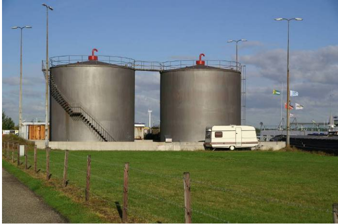
Figuur 13 Opslagtanks Dinteloord
