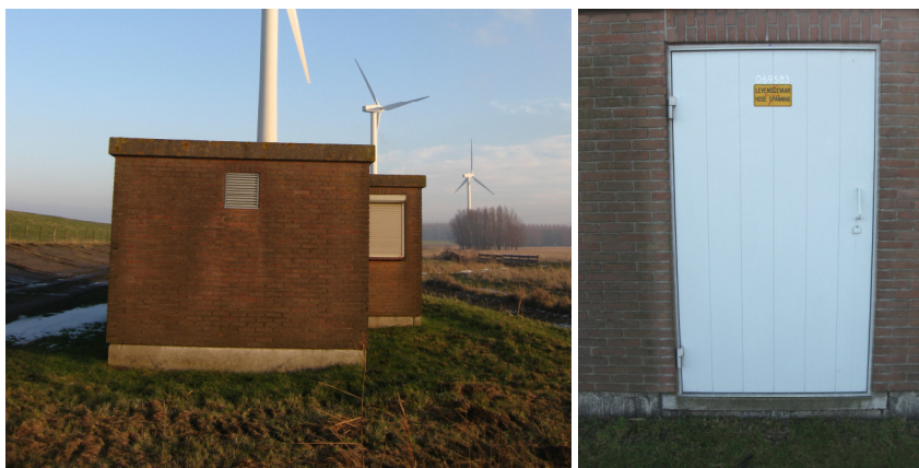
Figuur 22 Transformatorhuis windmolenpark Halsteren
