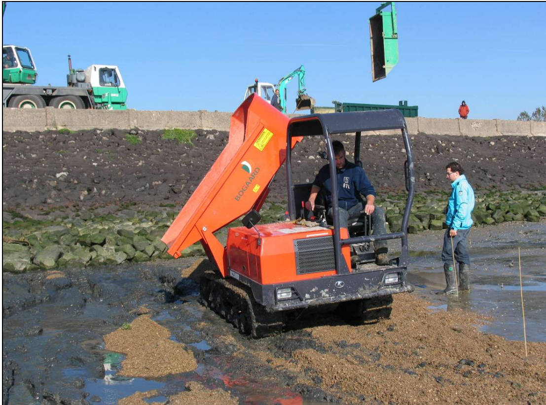
Foto 4. Schelpen worden op de korte proefstrook 'ingereden' mbv de rupsdumper.
