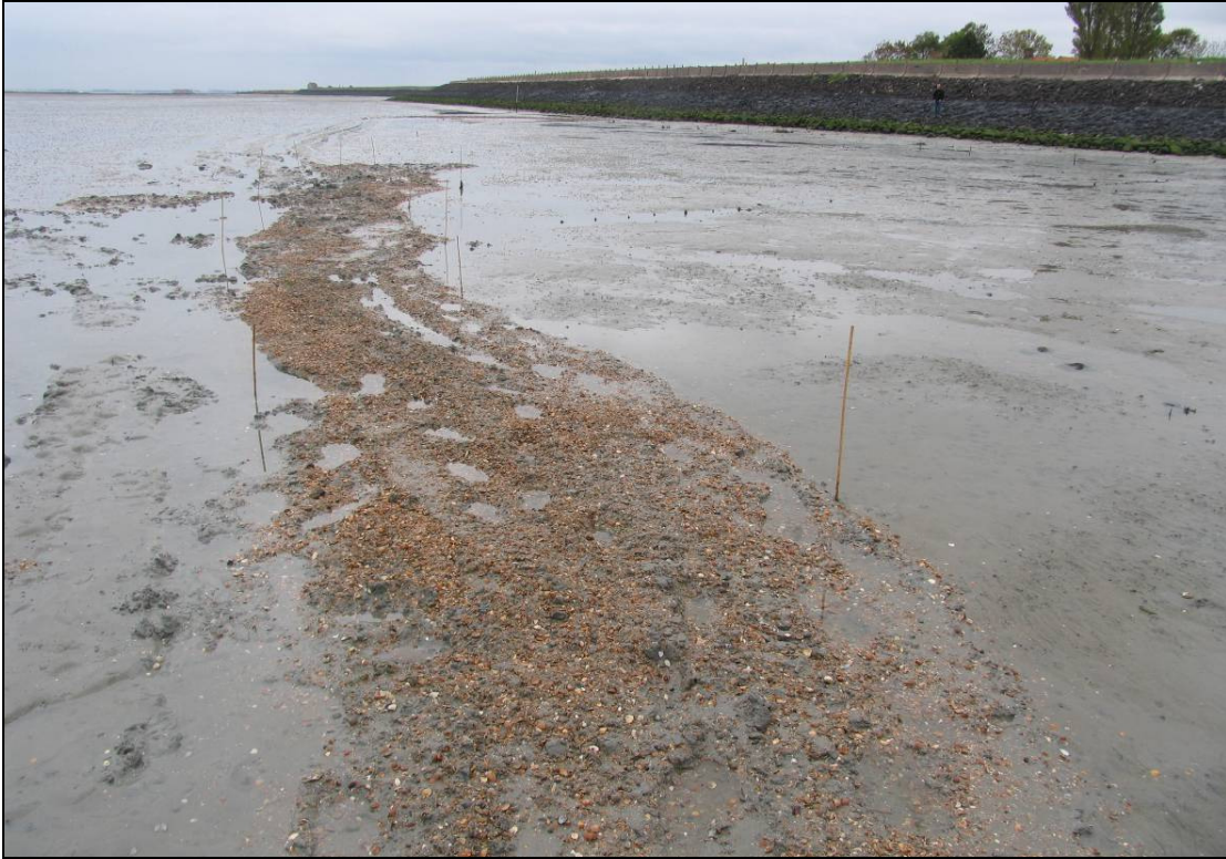
Foto 5. Ingefreezde schelpen op de lange proefstrook, 3 dagen na de aanleg
