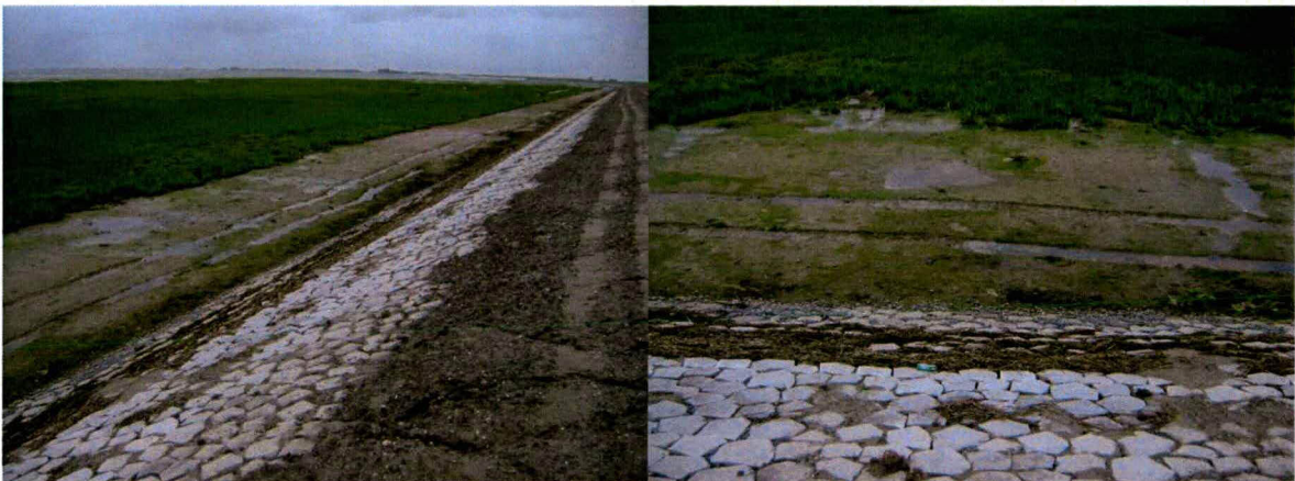
Bovenstaande foto laten zien dat in de werkstrook duidelijk een rijspoor zichtbaar is.
