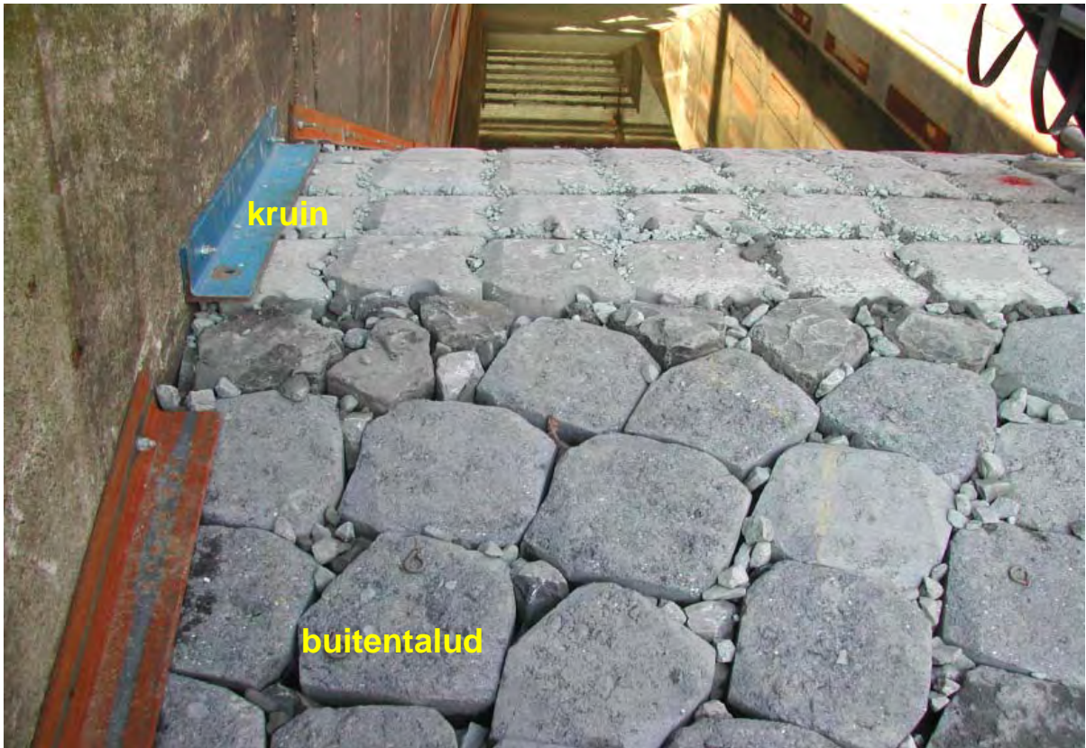
Aansluiting Basalton-buitentalud op Hydroblocks-kruin met enkele basalt zuilen (voor P11)
