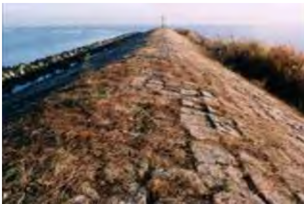
Figuur 1.2, Havendam van Ketelhaven
