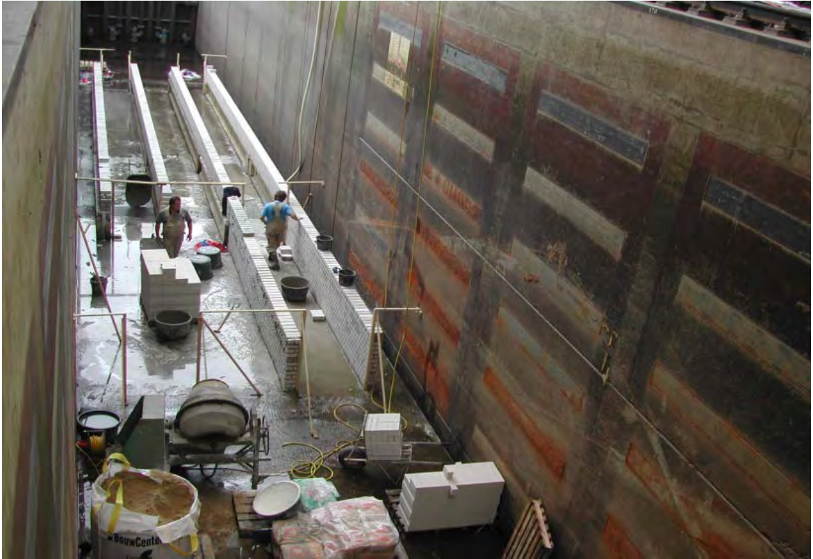
Bouw van ondersteuning tweede vloer
