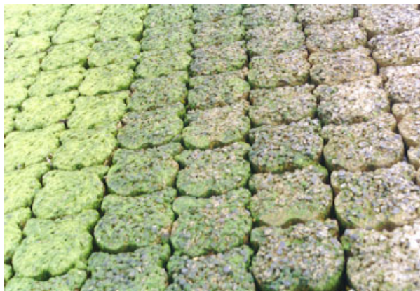
Figuur 11; Haringman hydroblock met ecotoplaag van uitgewassen lavasteen (ECO-zuil)
