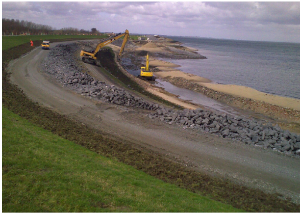
Figuur 8; Aanleggen van een kreukelberm
