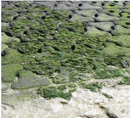
Figuur 36; Alternatieve betonsoorten, in dit geval C-fix, afgestrooid met lavasteen. Deze alternatieve betonsoort is afgestrooid met lavasteen tijdens de verwerking. (Soms wordt er ook gesproken over lavaslakken, dit is echter hetzelfde als lavasteen, puur natuurproduct)
