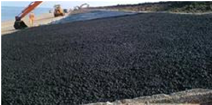
Figuur 25; Open steenasfalt
