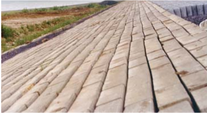
Figuur 30; Herzette Haringman betonblokken
