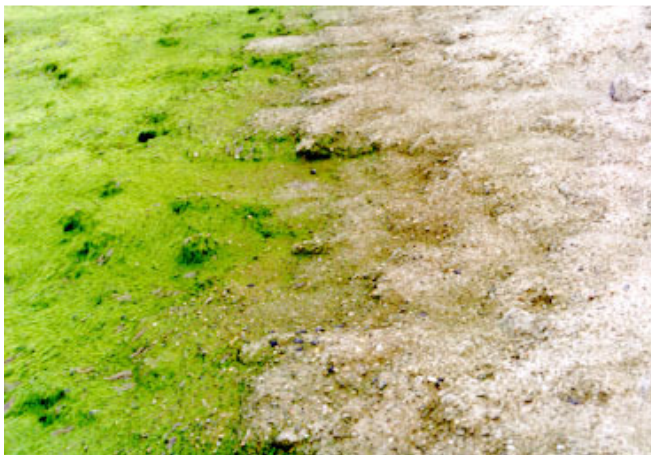
Figuur 80; Breuksteen 10-60 kg, gepenetreerd met open colloïdaal beton
