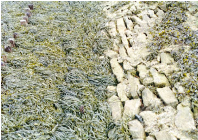
Figuur 82; Vilvoordse kalksteen, benedenbeloop gepenetreerd met colloïdaal beton
