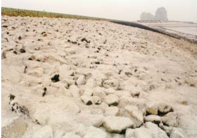
Figuur 83; Colloïdale betonpenetratie van Vilvoordse steen
