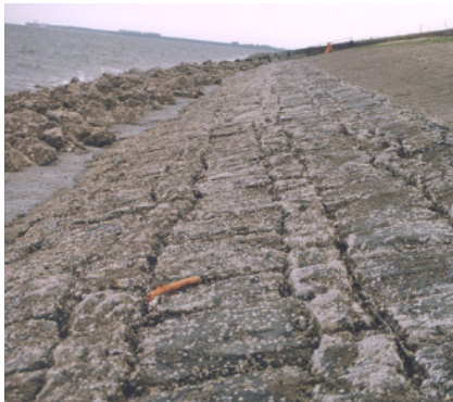
Figuur 37; Natuursteen herzet, in dit geval Doornikse steen. Dit is een afbeelding van Doornikse steen.
