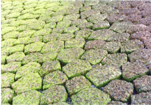
Figuur 85; Basalton, betonzuilen met toplaag van basaltplit
