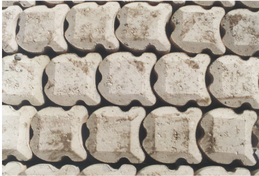
Figuur 33; Betonzuilen, in dit geval Haringman Hydroblocks Bonzuilen zijn zuilen van beton die geproduceerd worden voor de dijkbekleding, met een hoogte van 40-45 cm.
