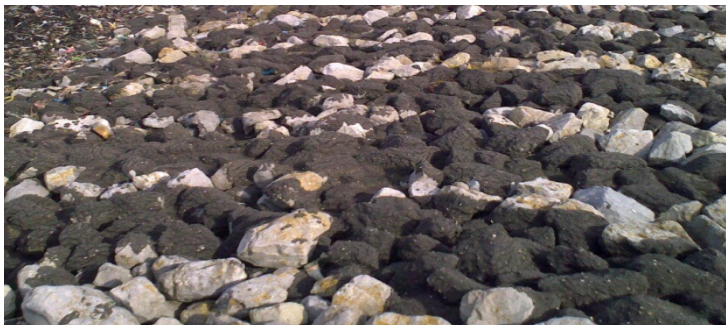
Figuur 29; Breuksteen met patroonpenetratie van gietasfalt
