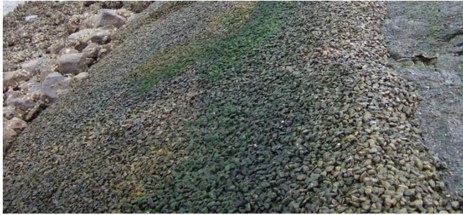
Figuur 39; Gelijkde steenslag, in dit geval Elastocoast PU is een twee componentenlijm die in staat is stenen (voornamelijk breuksteen) zo op elkaar te lijmen dat er een zeer sterk en poreus composietmateriaal ontstaat. Gelijkde steenslag is steenslag vermengd met PU.
