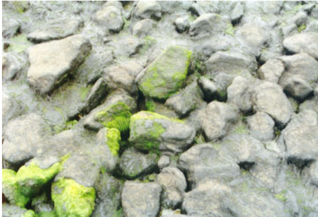
Figuur 27; Breuksteen vol en zat gepenetreerd met gietasfalt
