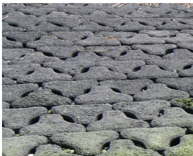
Figuur 35; Alternatieve betonsoorten, in dit geval C-fix Een alternatieve betonsoort is er bijvoorbeeld één uit aardolie geproduceerd, met daardoor een koolstofrijk bindmiddel. Door het te mengen met toeslagstoffen worden composietmaterialen verkregen met eigenschappen die tussen cementbeton en asfalt in liggen. Door koolstofrijke aardoliefracties toe te passen in constructiematerialen in plaats van te verbranden, wordt koolstof duurzaam gebruikt en daarmee de CO 2 emissie gereduceerd.
