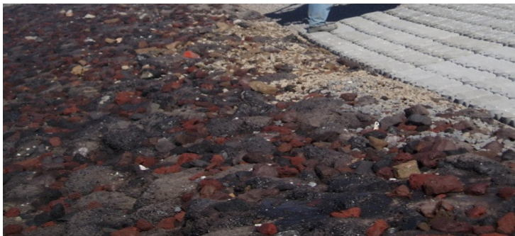
Figuur 28; Breuksteen afgestrooid met lavasteen
