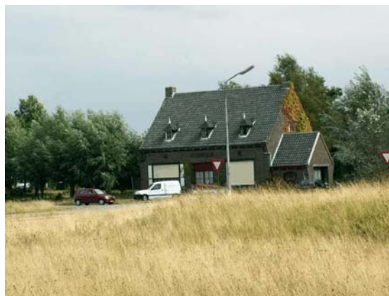
Huis op het noordelijke deel van het veerplein met verblijfplaats van Gewone dwergvleermuis.
