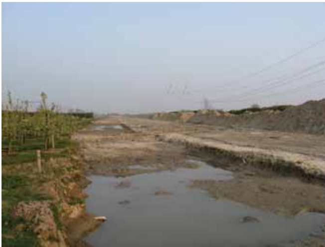
Figuur 3.3. Grondwerken in de Karelpolder, april 2008 (JK).
