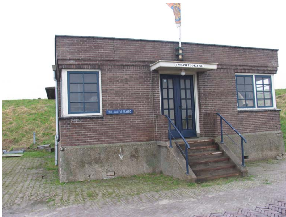
Figuur 2: Wachtruimte van de voormalige veerdienst
