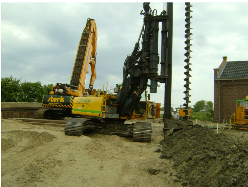
Foto 6-1 Grondverwijderend voorboren.
