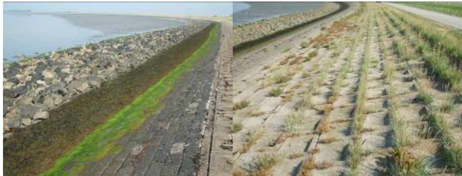
Foto 2.1: De kreukelberm en koperslabblokken (ondertafel) en haringmanblokken (boventafel) op de Oesterdam Noord.
