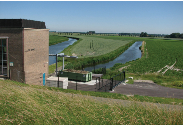
Figuur 3.7. Gemaal de Noord en de twee daarin uitwaterende watergangen, 24 juni 2009 (jwv).
