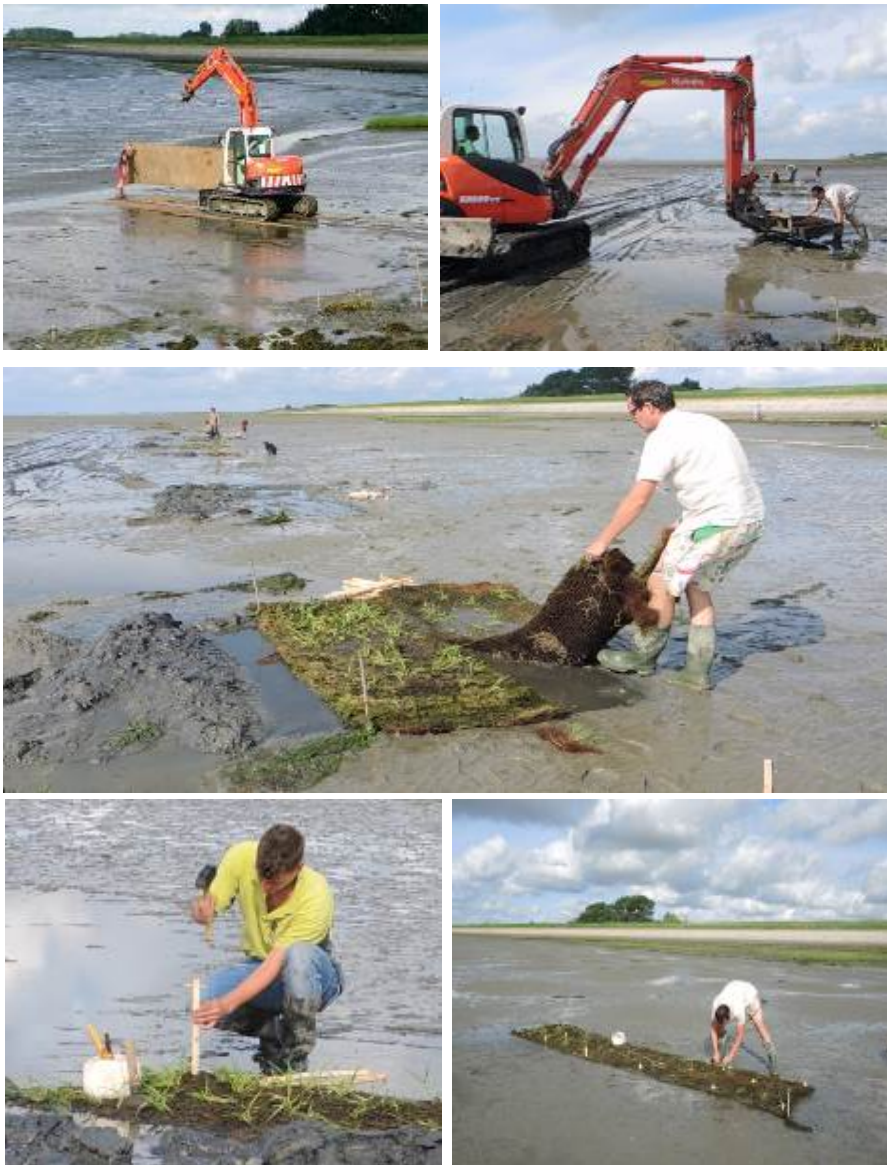
Figuur 9. Plaatsing van de matten. Linksboven: aanleg van metalen beplating op zachte slik bij Viane om de experiment locatie bereikbaar te maken. Rechtsboven/onder: plaatsing van de matten op het slik.
