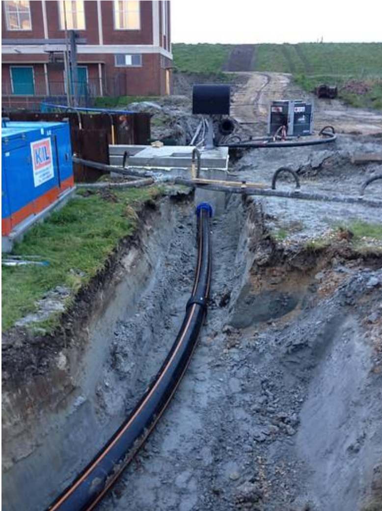
Aanleg vispassage op Schouwen-Duiveland, foto Beeldbank Waterschap Scheldestromen
