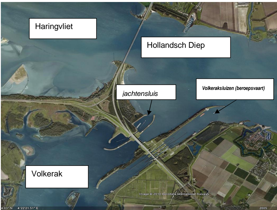
Figuur 1.1 De Volkeraksluizen vormen de verbinding tussen het Volkerak en het Hollandsch Diep. De scheepvaartsluizen bestaan uit 3 beroepsvaartsluizen en 1 jachtensluis. (Bron: Google Earth)
