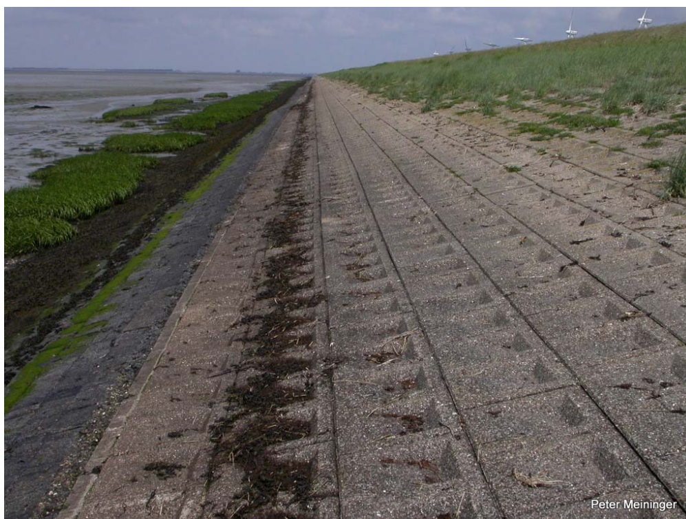
Foto 1. Oesterdam met zone koperslakblokken, zone Haringmanblokken kaal en begroeid met zoutplanten.
