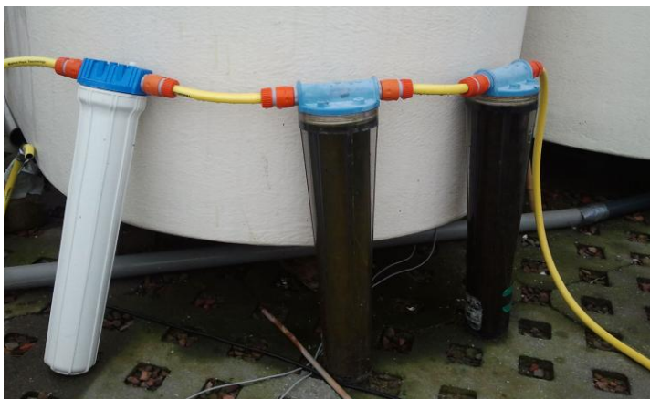
Fig. 6: kaarsfilter, 25, 5 en 0,2 \mu\text{m}
