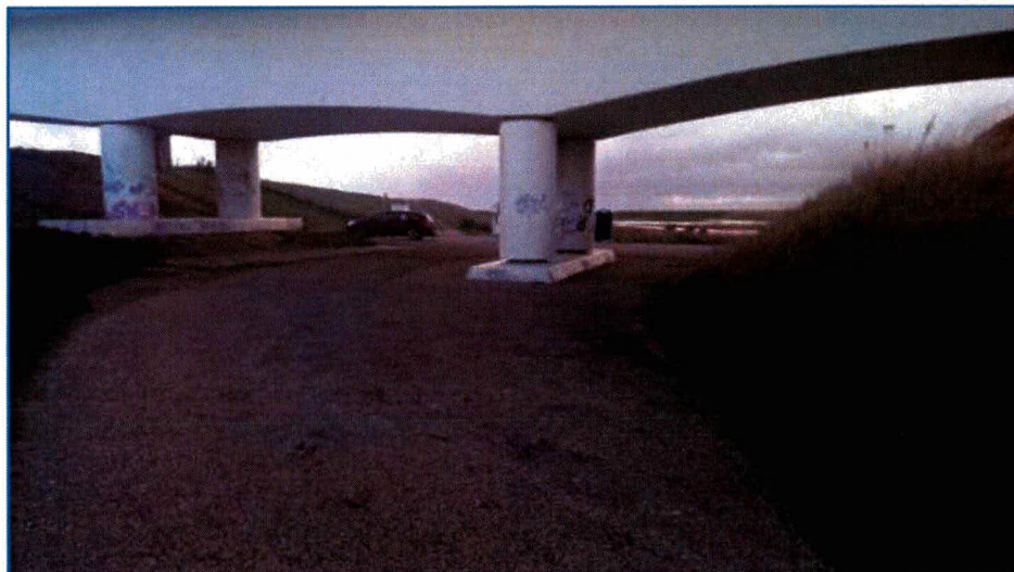
Fig. 5.1 Depotlocatie op verharding onder Zeelandbrug
