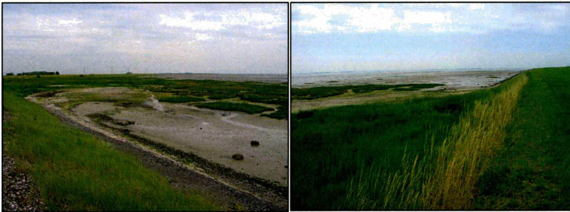
Figuur 1: geërodeerde deel van het schor langs de dijk bij dijktraject Stavenisepolder. Op de rechterfoto is de vegetatie van strandkweek zichtbaar op de te hoog afgewerkte werkstrook.
