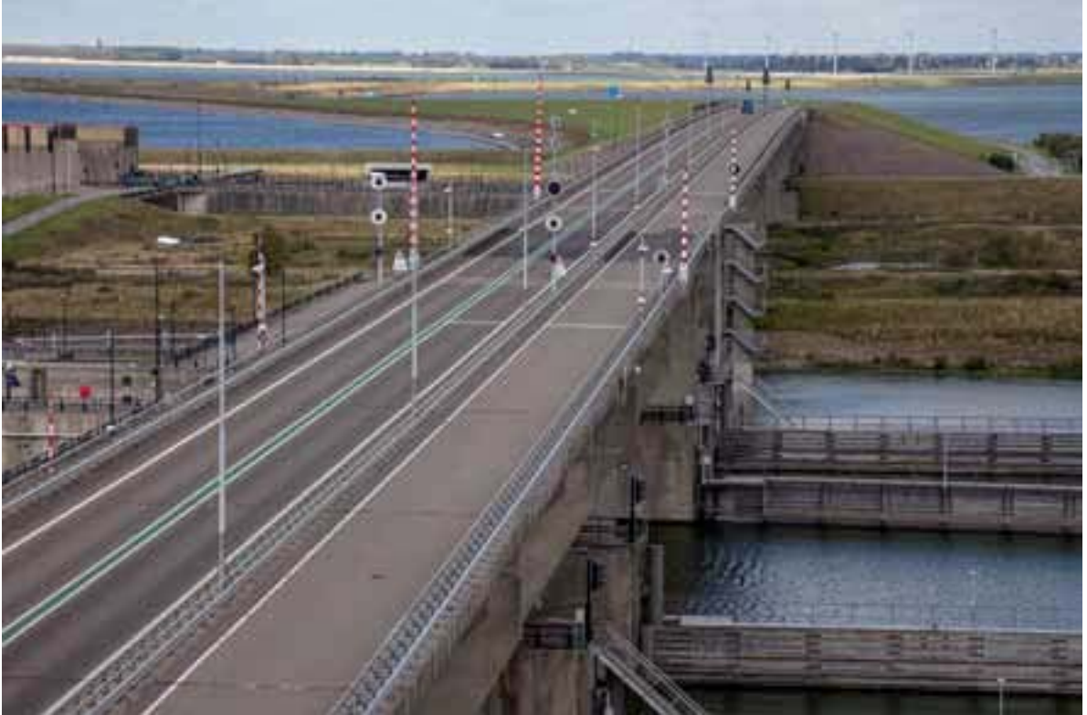
Krammersluizen-schakel tussen Oosterschelde (links) en Volkerak (rechts)
