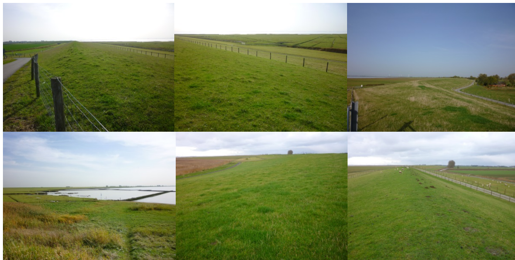
Figuur 1.3 Dijken langs het Duitse deel van de Dollard (met een groen kweldervoorland).
