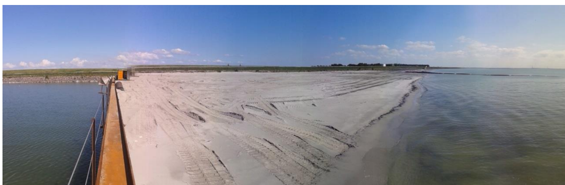
Figuur 9 Overzicht aangebrachte zand.
