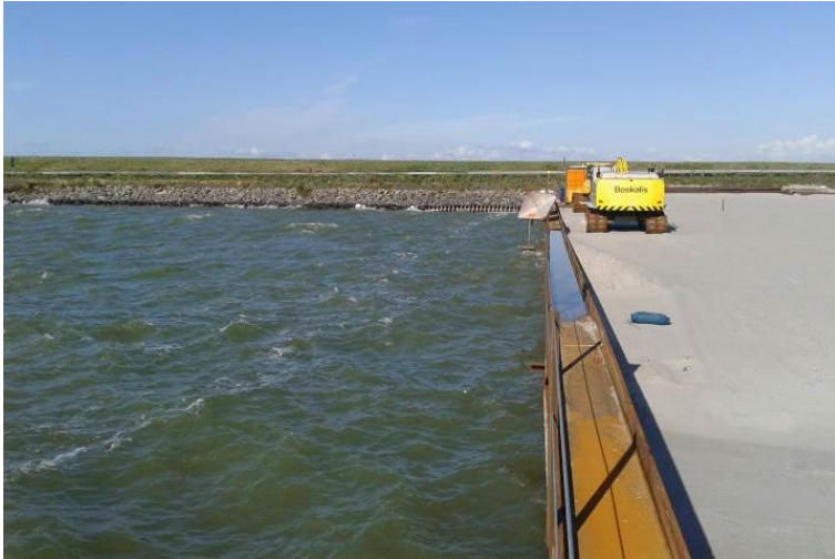
Figuur 4 Aanbrengen gording op damwand.
