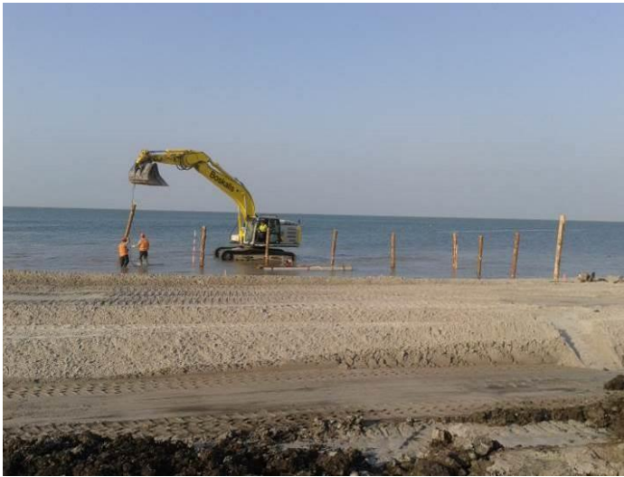
Figuur 13 Aanbrengen palen t.b.v. rijsmatconstructie.
