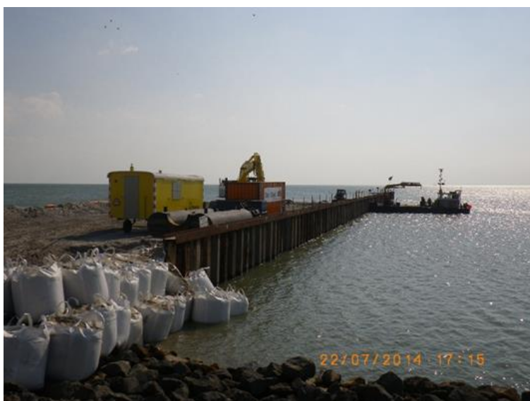
Figuur 7 Geplaatste geocontainers tussen dijk en begin damwand.
