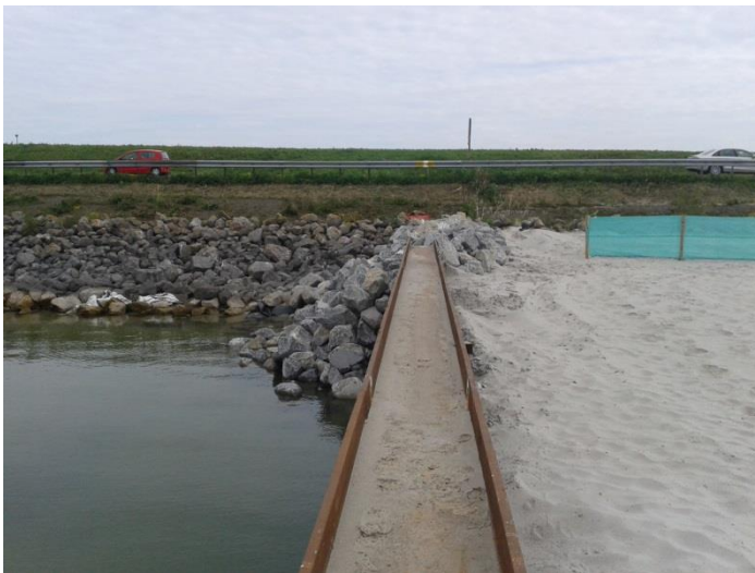
Figuur 11 Begin stuifscherm naast damwand.
