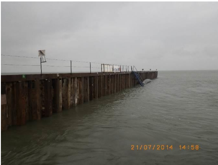
Figuur 5 Damwand gereed.
